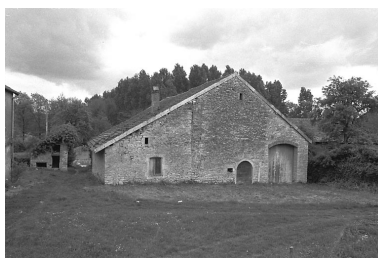
Façade postérieure. Phot. Bernard Lardière IVR43_19817000545Z
