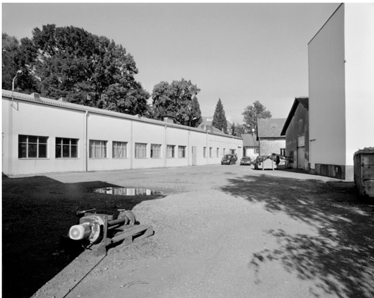
Atelier de fabrication depuis le sud-est.
