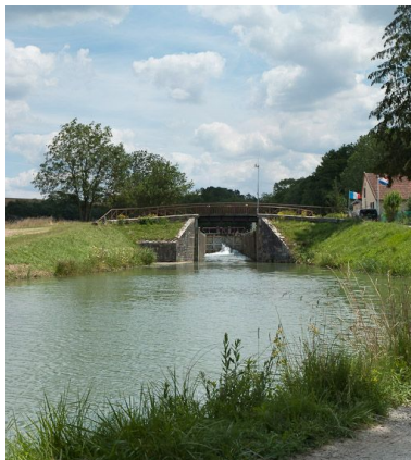
Vue du pont depuis l'aval. Phot. Pierre-Marie Barbe-Richaud IVR26_20118900290NUC2AQ
