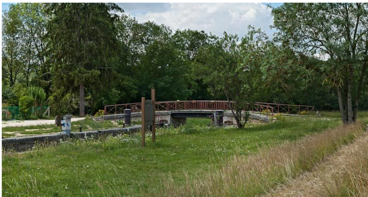
Vue du pont depuis l'amont.
