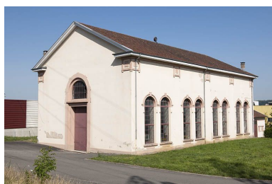
Salle des machines. Phot. Jérôme Mongreville IVR43_20112501245NUC4A
