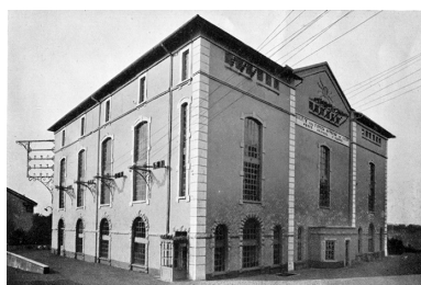
SOUS-STATION PRINCIPALE D'ÉTUPES : Vue générale.
