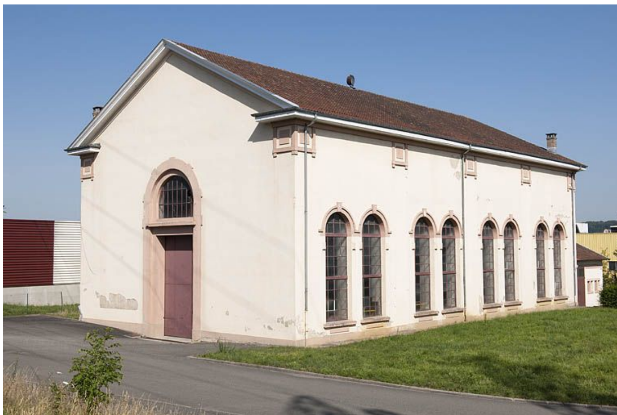
Salle des machines.
