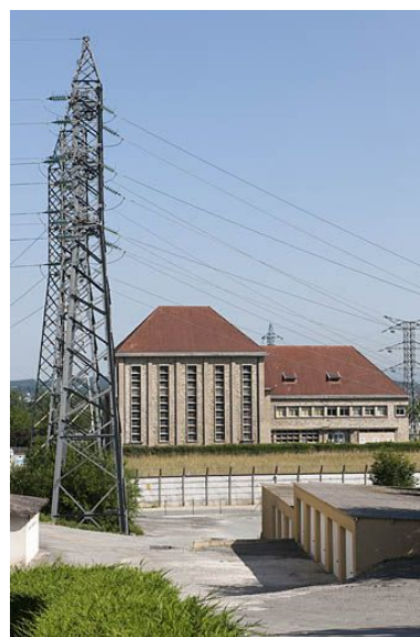
Nouveau poste de transformation. Phot. Jérôme Mongreville IVR43_20112501249NUC4A
