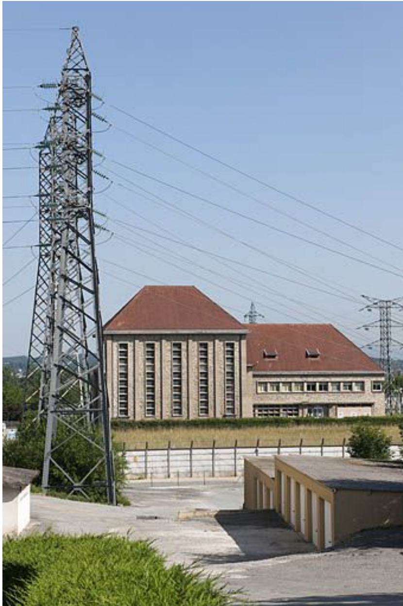
Nouveau poste de transformation.
