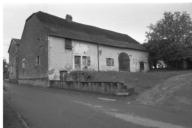
Vue d'ensemble. Phot. Bernard Lardière IVR43_19817000277Z
