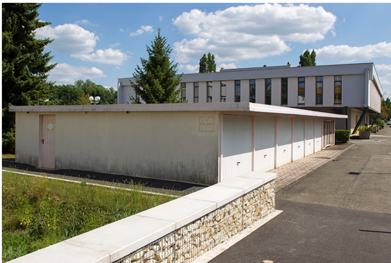
Vue d'ensemble des fa ades ouest du local   v lo et garages et de la cantine.
