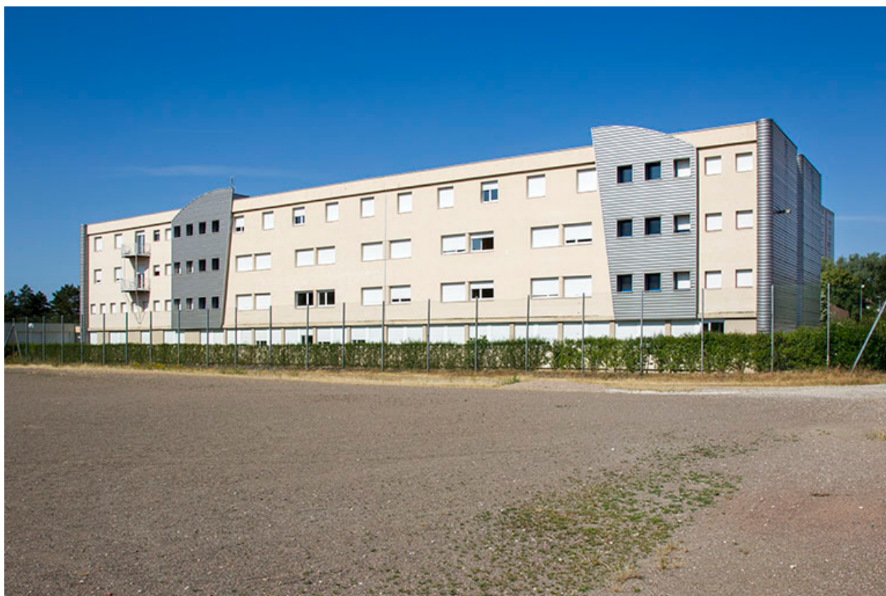
Fa ade est et pignon nord de l'internat.
