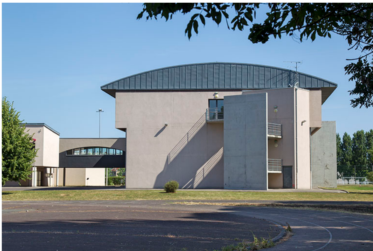
Pignon sud de l'externat est.
