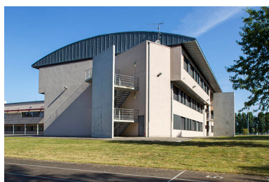
Angle sud-est de l'externat est. Phot. Sonia Dourlot IVR43_20147000209NUC2A
