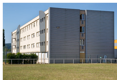
Pignon nord de l'internat.
