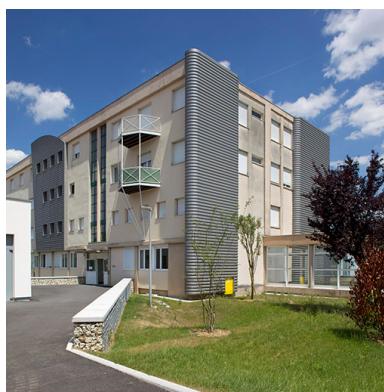
Angle sud-ouest, pignon sud de l'internat.
