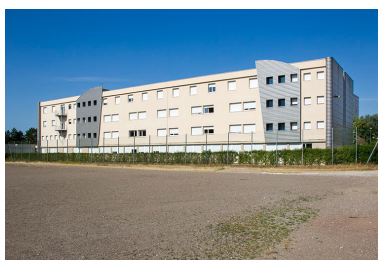
Fa ade est et pignon nord de l'internat.
