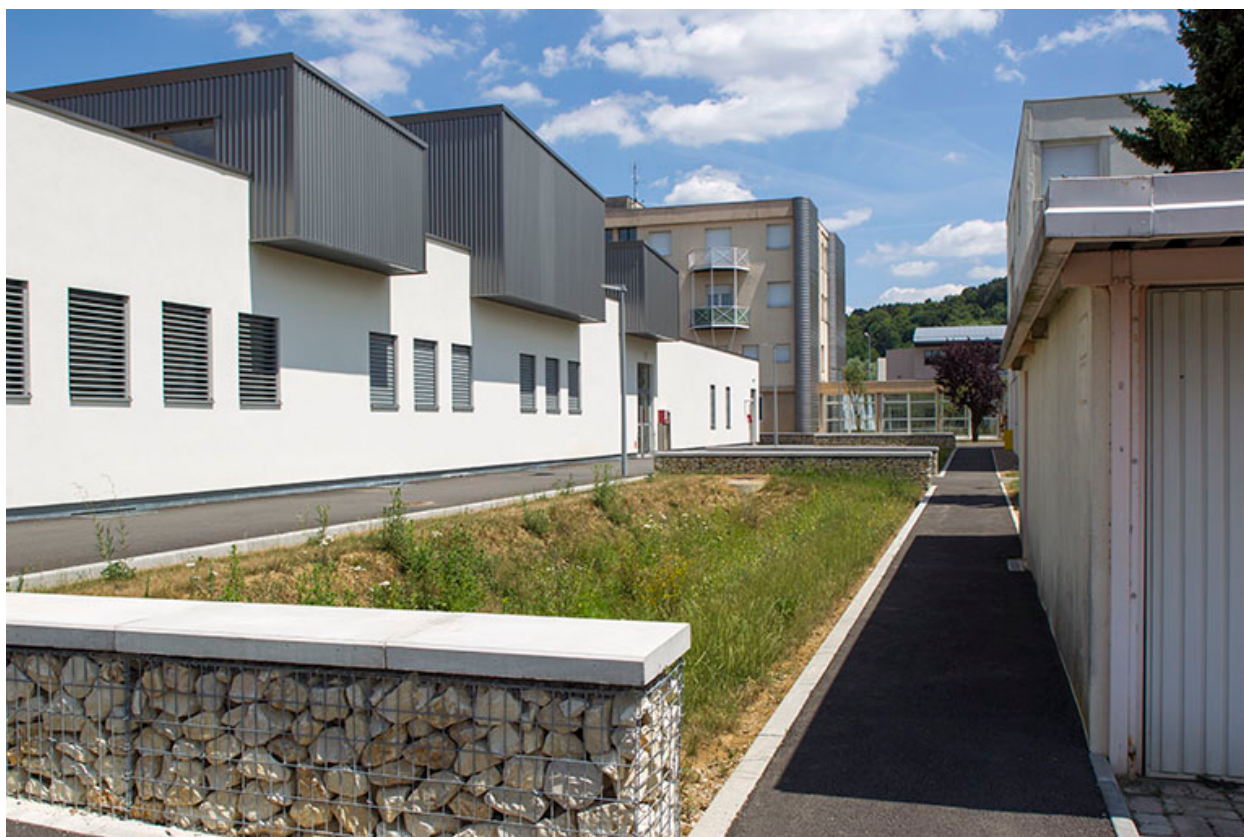
Fa ade sud du p le h telier, vue de trois-quart sud-ouest.
