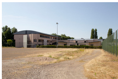
Fa ades et pignons nord des externats depuis le stade au nord. Phot. Sonia Dourlot IVR43_20147000201NUC2A
