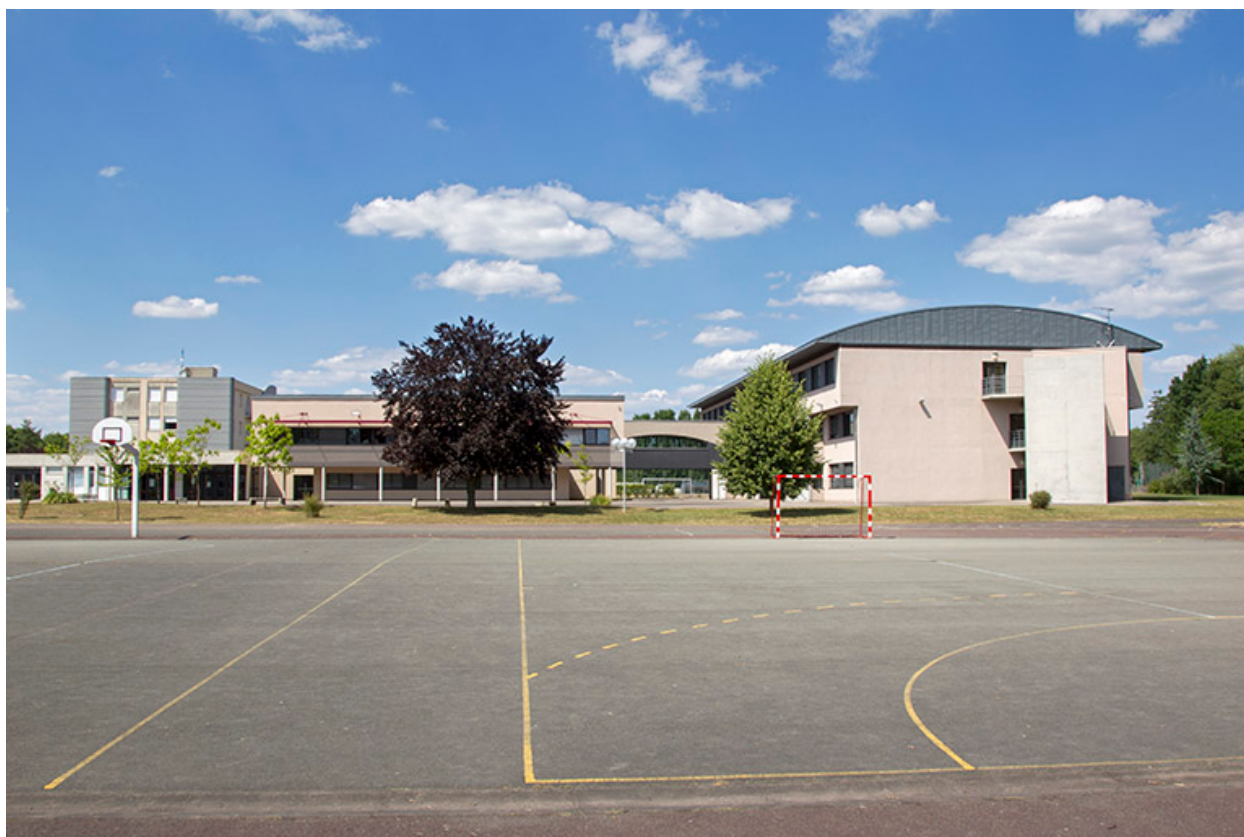
Terrain de sport et fa ades et pignon sud des externats.
