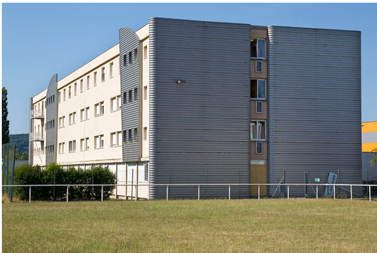
Pignon nord de l'internat.
