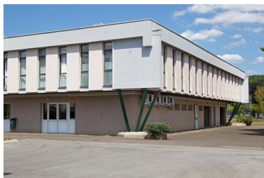
Angle sud-ouest de la cantine. Phot. Sonia Dourlot IVR43_20147000225NUC2A
