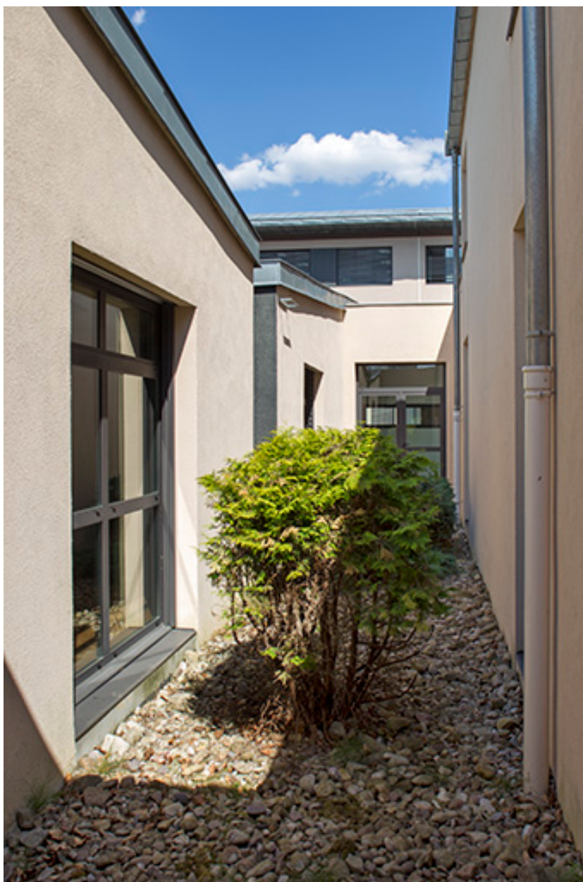
Puits de lumi re jouxtant le centre de documentation et d'information.
