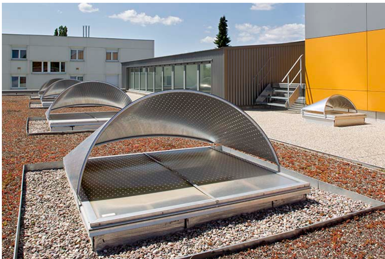
D tails des terrasses sud du p le h telier, vus du nord.
