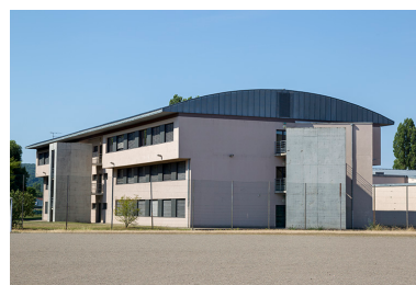
Externat est vue de trois-quart nord-est. Phot. Sonia Dourlot IVR43_20147000213NUC2A
