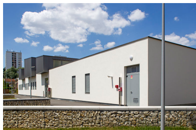
Fa ade sud du p le h telier, vue de trois-quart sud-est. Phot. Sonia Dourlot IVR43_20147000179NUC2A
