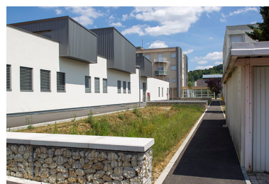
Fa ade sud du p le h telier, vue de trois-quart sud-ouest. Phot. Sonia Dourlot IVR43_20147000177NUC2A
