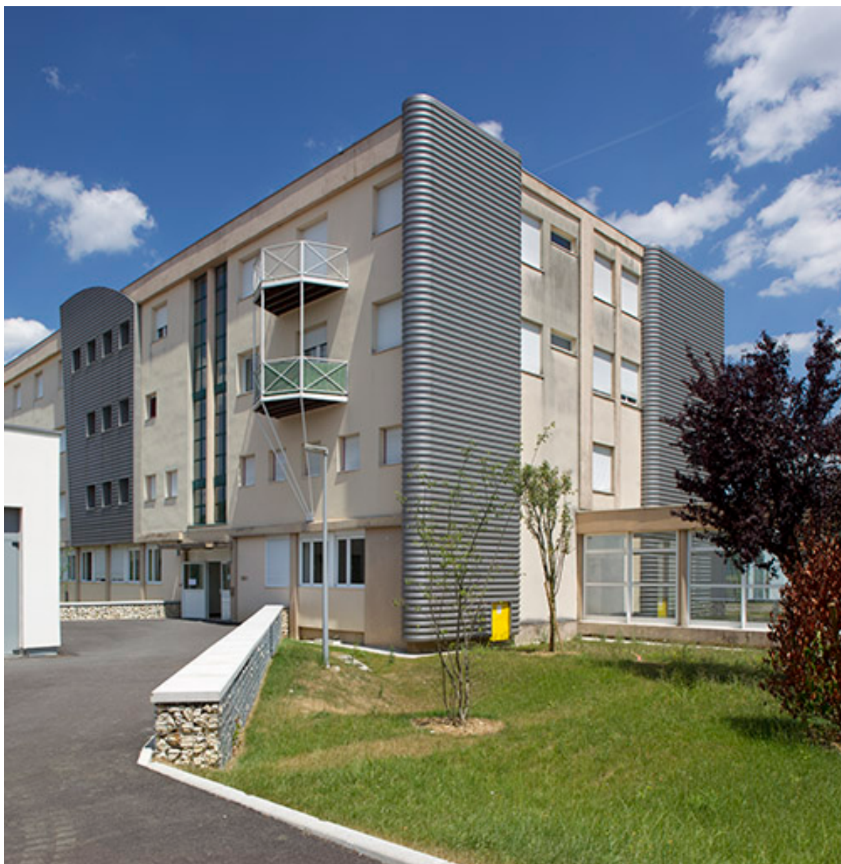
Angle sud-ouest, pignon sud de l'internat.
