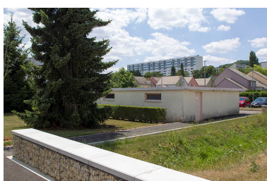
Fa ade post rieure est et pignon nord du local   v lo et garages. Phot. Sonia Dourlot IVR43_20147000227NUC2A
