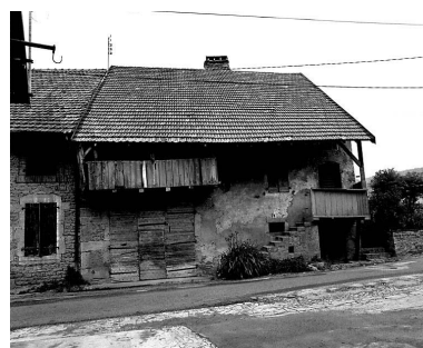
Ferme située 9 rue de l'Isle aux Prêtres. Phot. Yves Sancey IVR43_19812500320X
