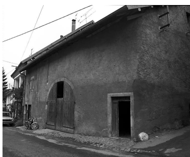
Ferme située 5 rue de l'Isle aux Prêtres. Phot. Yves Sancey IVR43_19812500317X
