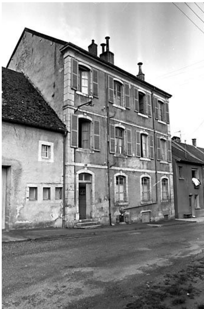
Maison située 28 rue du Seult.
