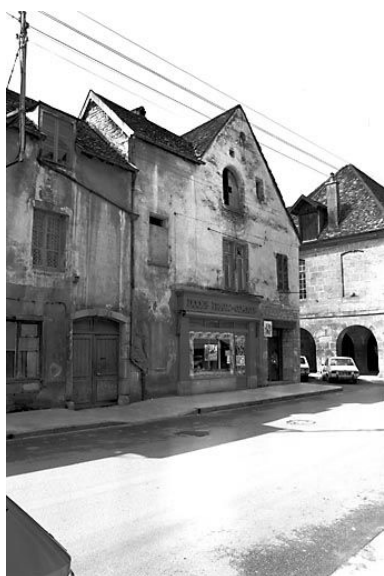
Maison située 30-32 rue Pierre Vernier. Phot. Yves Sancey IVR43_19772500229X
