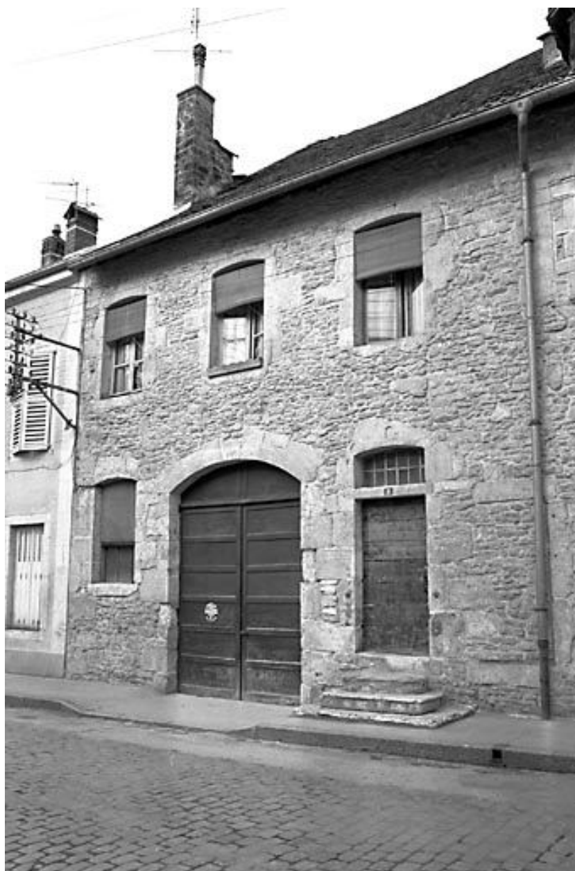
Maison située 8 rue Saint-Laurent.
