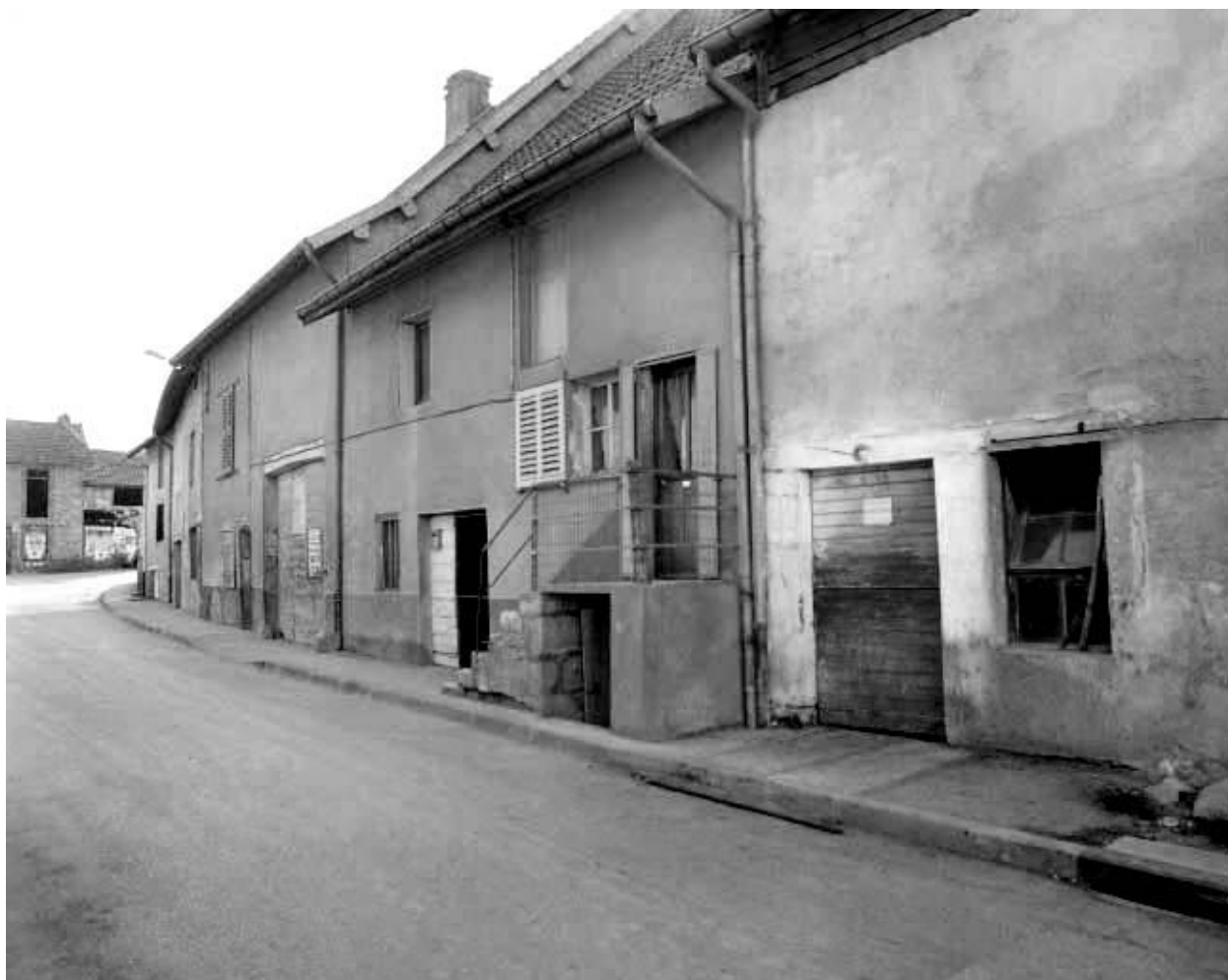
Maison de vigneron située 4 rue des Contrevaux.
