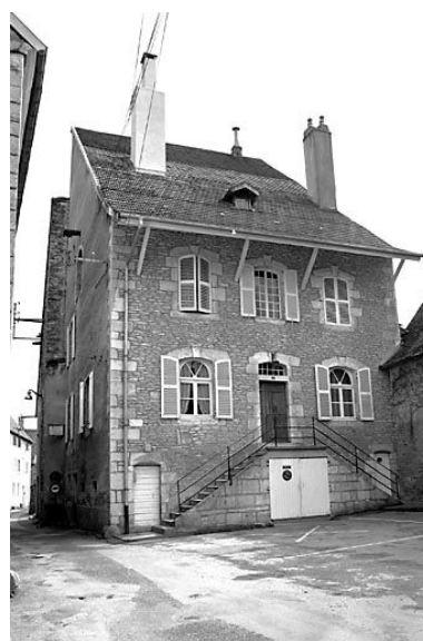
Maison située 4 rue de la Froidière. Phot. Yves Sancey IVR43_19772500080X
