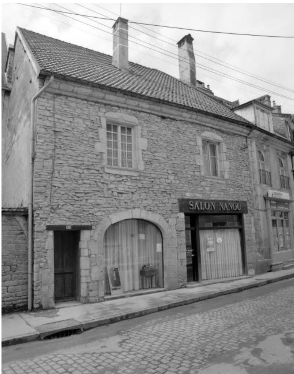
Maison située 9 rue Saint-Laurent.
