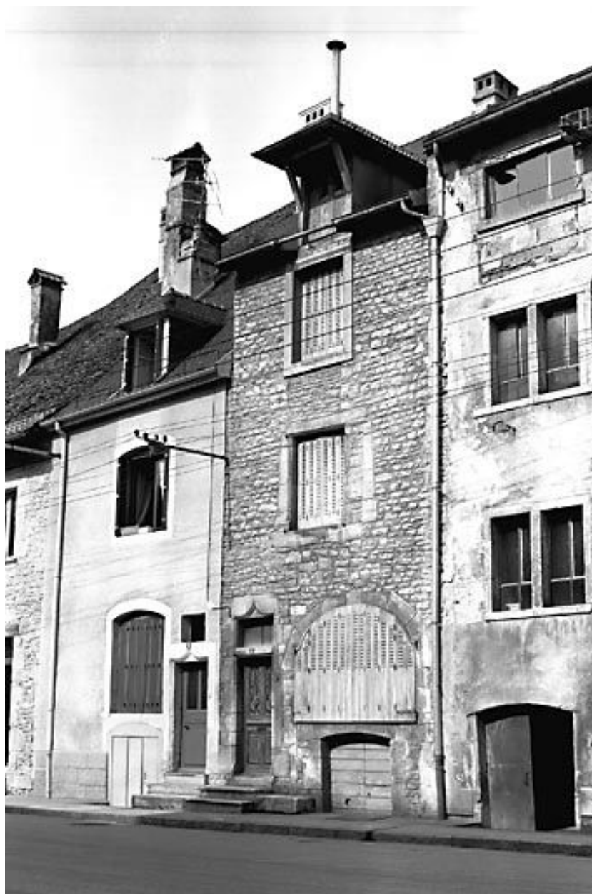
Maison située 4 rue Saint-Laurent.
