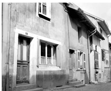
Maisons situées 7 et 9 rue des Martinets. Phot. Yves Sancey IVR43_19772500133X
