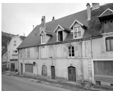
Maison située 5 avenue du Président Wilson. Phot. Yves Sancey IVR43_19772500070X
