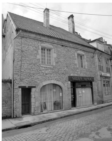
Maison située 9 rue Saint-Laurent.
