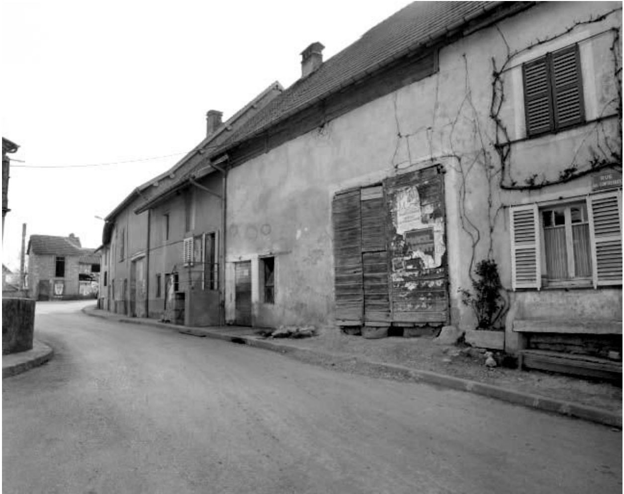
Ferme située 2 rue des Contrevaux.
