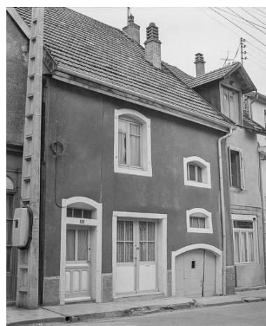
Maison de vigneron située 44 rue Eugène Cusenier. Phot. Yves Sancey IVR43_19772500040X
