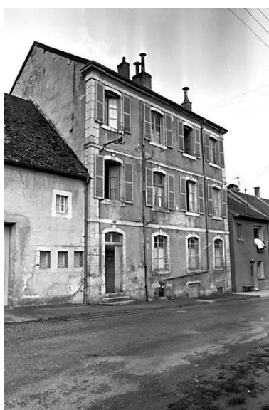
Maison située 28 rue du Seult. Phot. Yves Sancey IVR43_19772500209X
