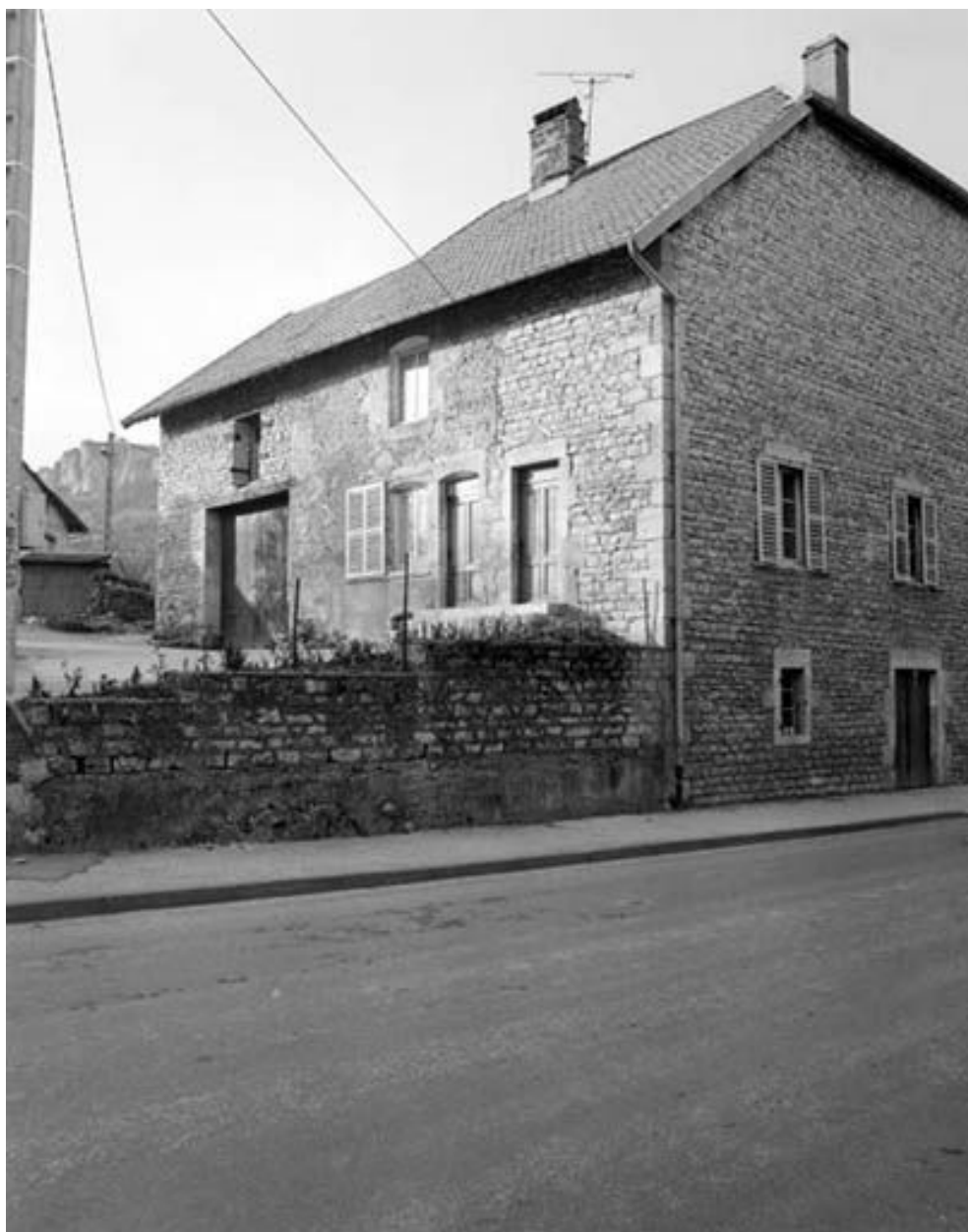
Ferme située 2 rue du Viaduc.
