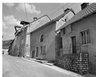
Maison de vigneron situ e 4 rue des Martinets. Phot. Yves Sancey IVR43_19772500227X
