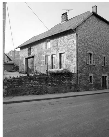
Ferme située 2 rue du Viaduc. Phot. Yves Sancey IVR43_19772500225X
