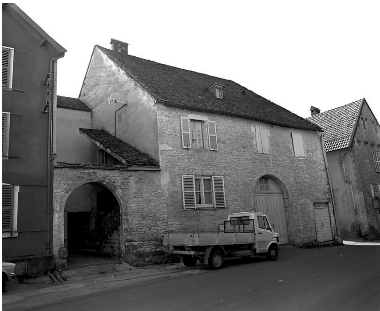
Maison située 8 rue Edouard Bastide.
