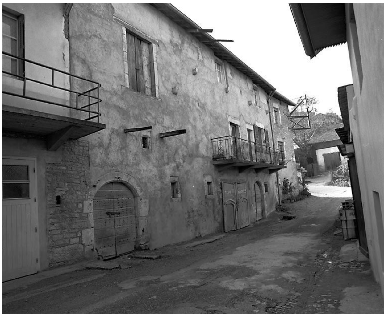
Maison située 1 chemin des Sablières.
