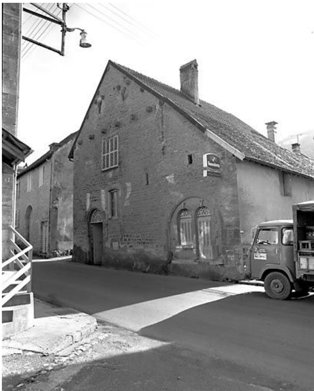
Maison située 6 rue Edouard Bastide.
