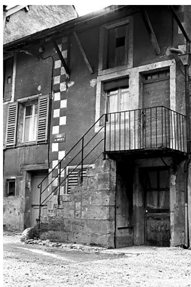
Maison de vigneron située 17 rue des Martinets. Phot. Yves Sancey IVR43_19772500128X
