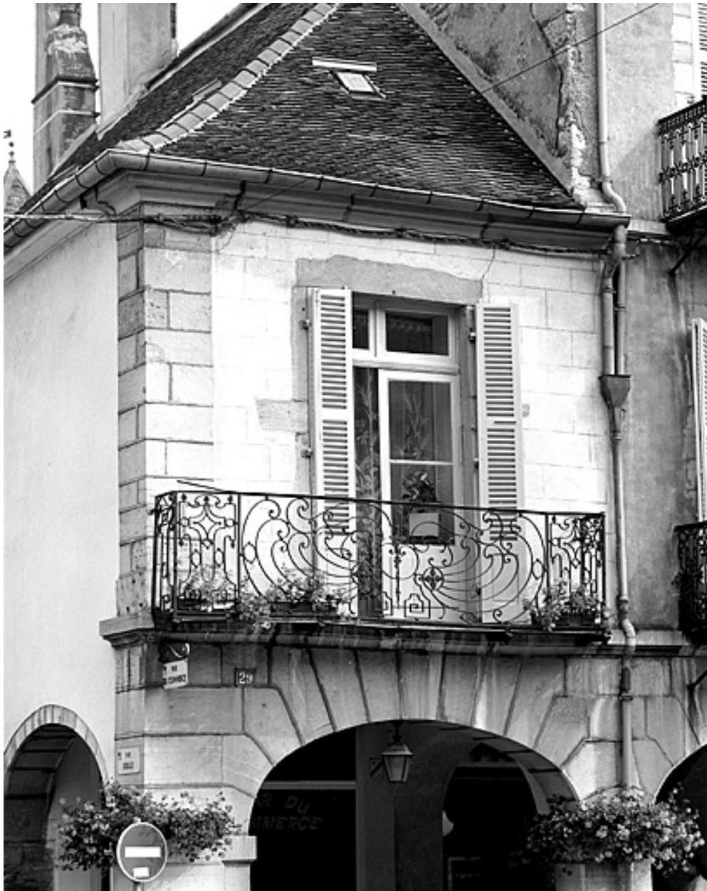
Façade antérieure, balcon.
