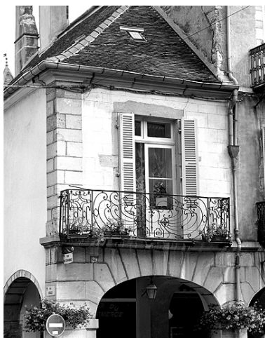
Façade antérieure, balcon. Phot. Yves Sancey IVR43_19833900292X
