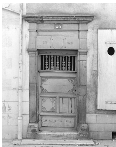
Façade latérale, porte d'entrée avec la date 1726. Phot. Yves Sancey IVR43_19833900624X
