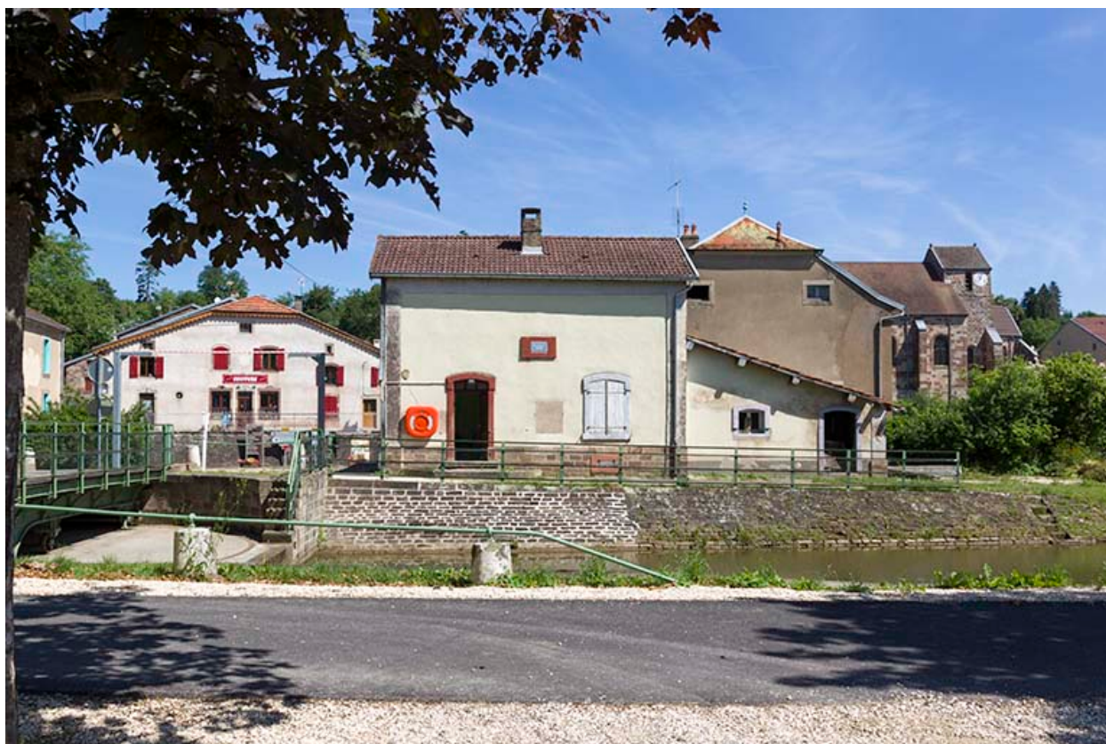
La maison du pontier.
