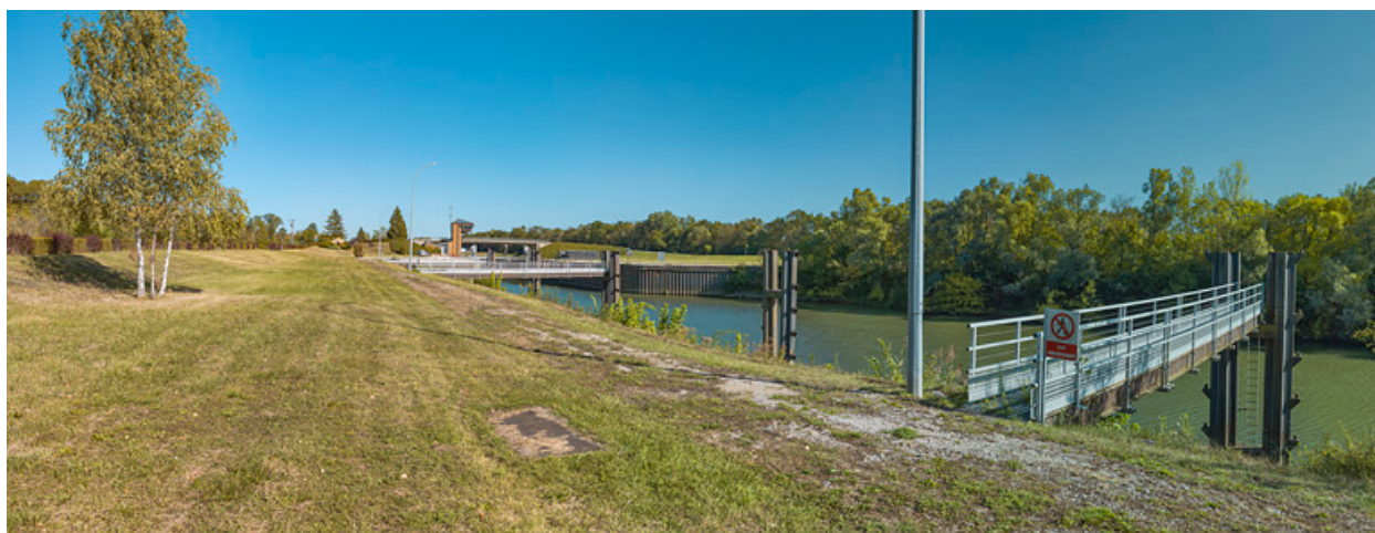
Le site d'écluse vu d'aval.
