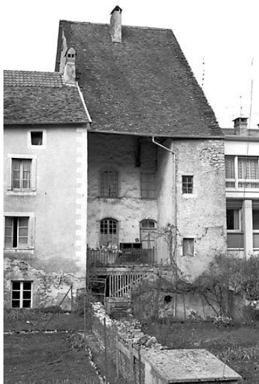
Façade postérieure. Phot. Yves Sancey IVR43_19772500192X
