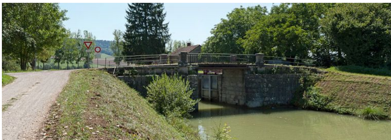
Vue du pont depuis l'amont.
