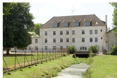
Façade antérieure depuis l'amont. Phot. Jérôme Mongreville IVR43_20097000820NUC2A
