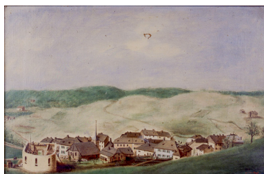
Morbier en 1835, l'église en construction. Phot. Jérôme Mongreville IVR43_19913900839XA
