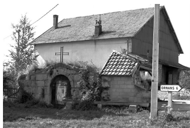
Vue générale. Phot. Yves Sancey IVR43_19802500904X
