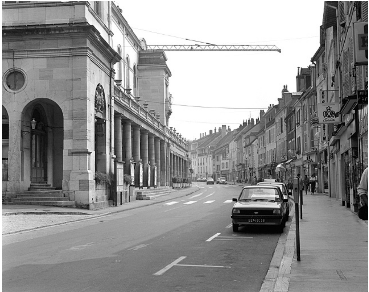
Façade latérale droite.
