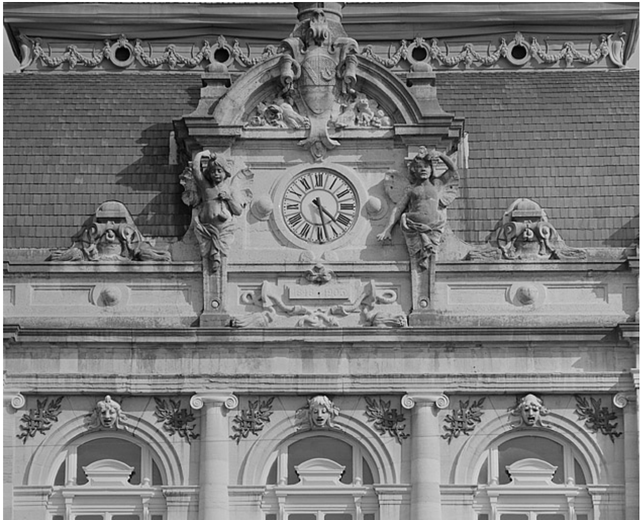
Façade antérieure, le couronnement.
