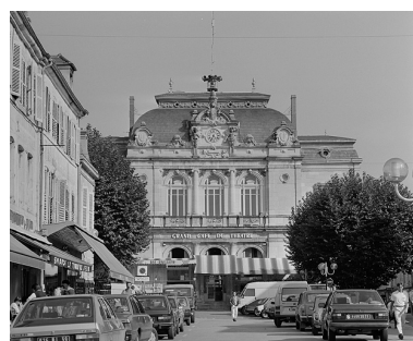
Façade antérieure, vue générale. Phot. Yves Sancey
