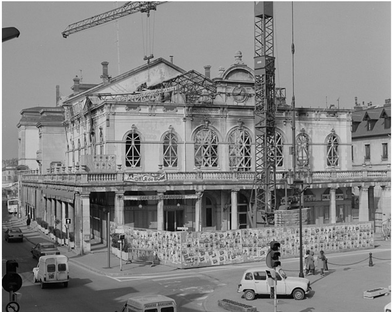
Façade postérieure (après l'incendie de 1983).
