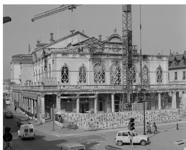
Façade postérieure (après l'incendie de 1983).
