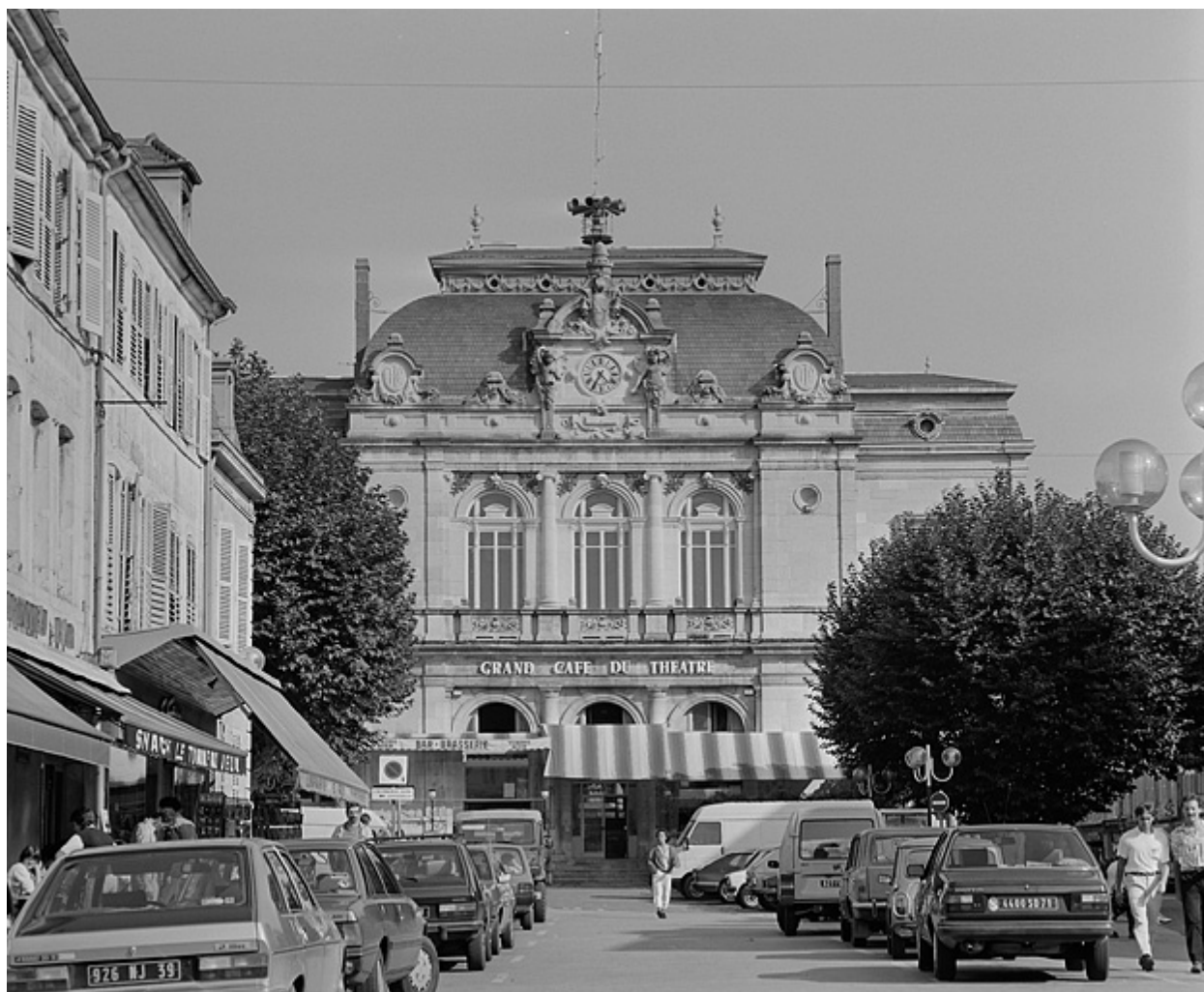
Façade antérieure, vue générale.
