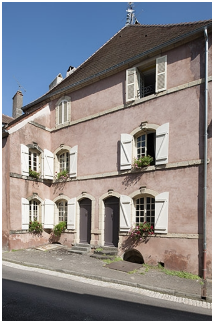
Vue générale de la façade postérieure rue Thiers.
