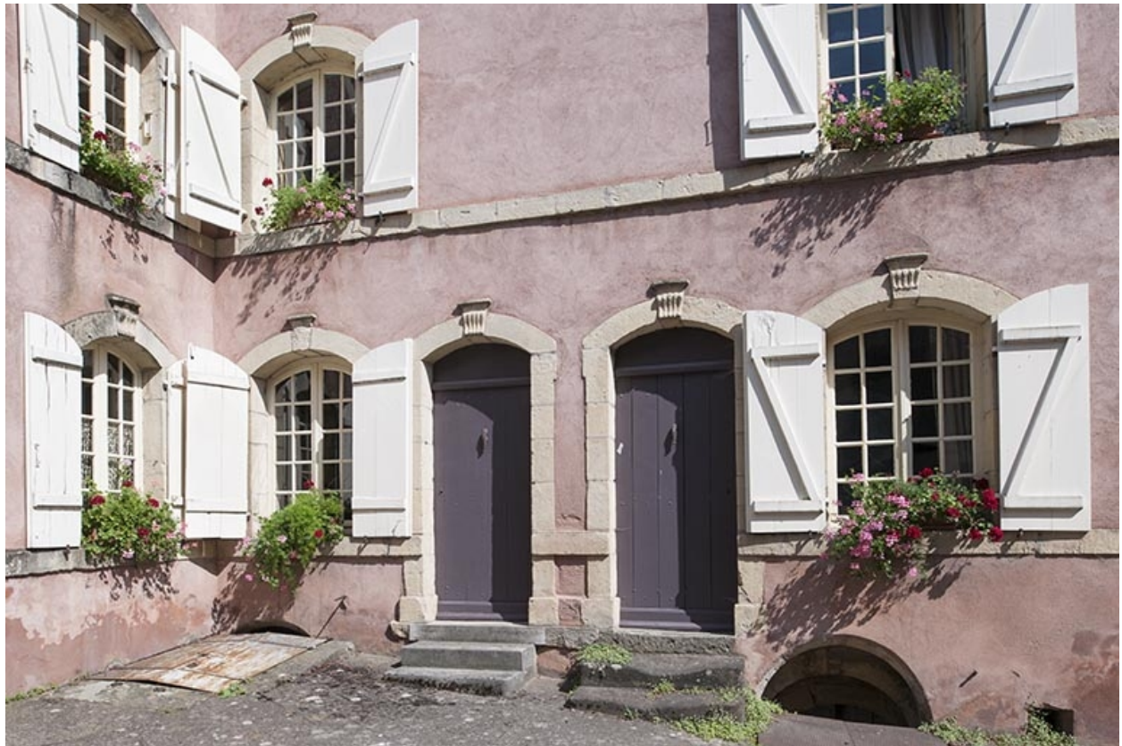
Détail de la façade postérieure, rue Thiers.
