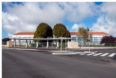
L'entrée principale le long du boulevard. Phot. Mary Ruffinoni IVR43_20142500025NUC4A
