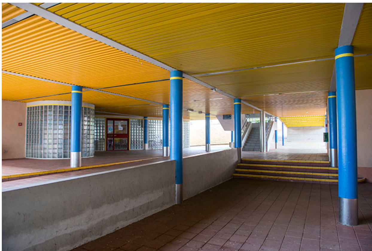
Vue intérieure de circulation abritée.
