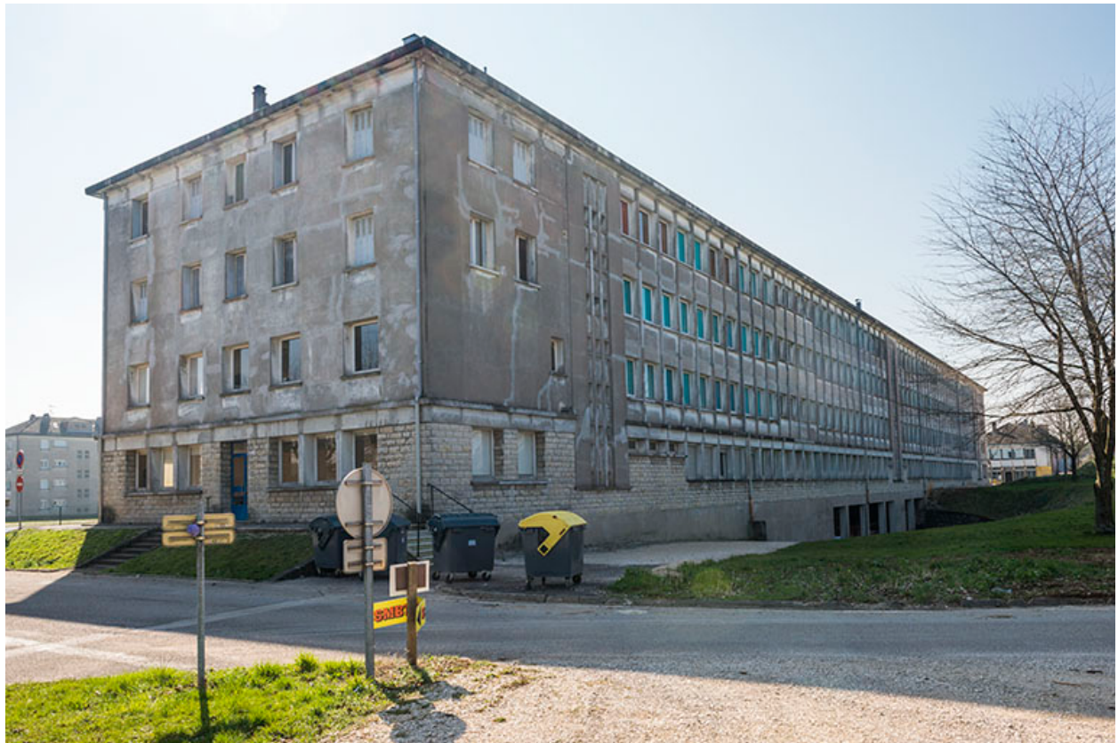
Façade postérieure de l'internat de filles.
