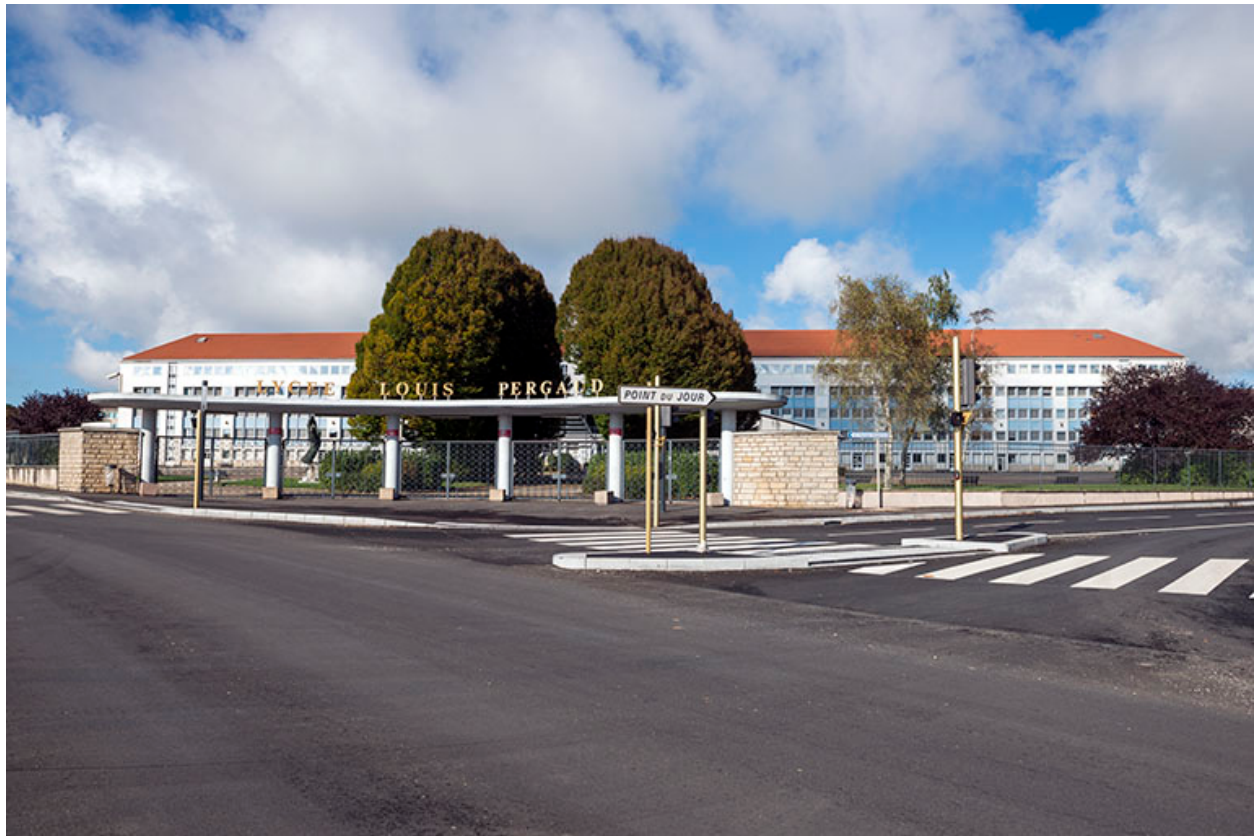
L'entrée principale le long du boulevard.
