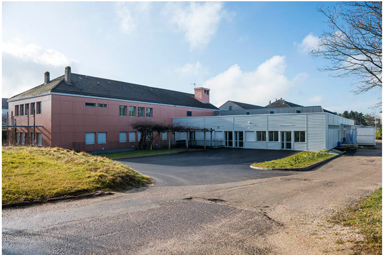
Vue de trois-quart des services communs.
