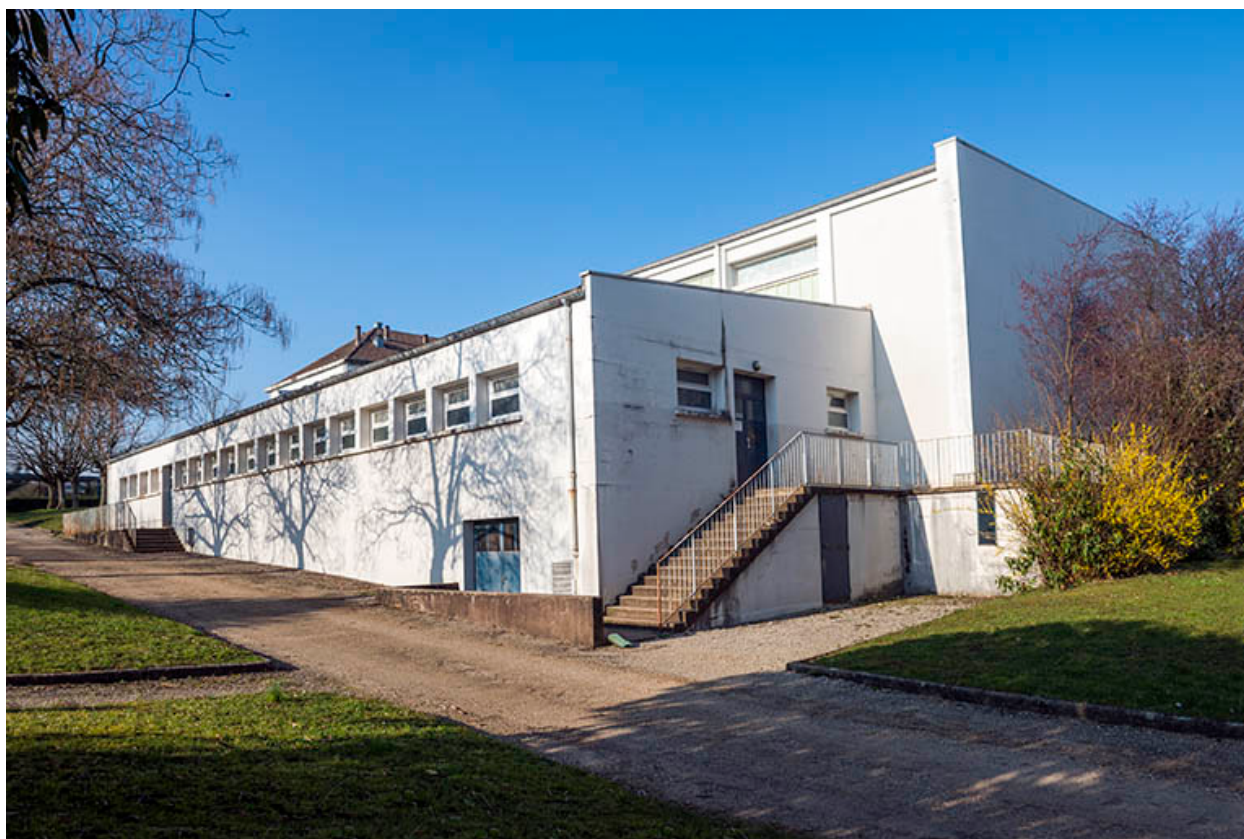
Façade nord-est du gymnase de garçons.
