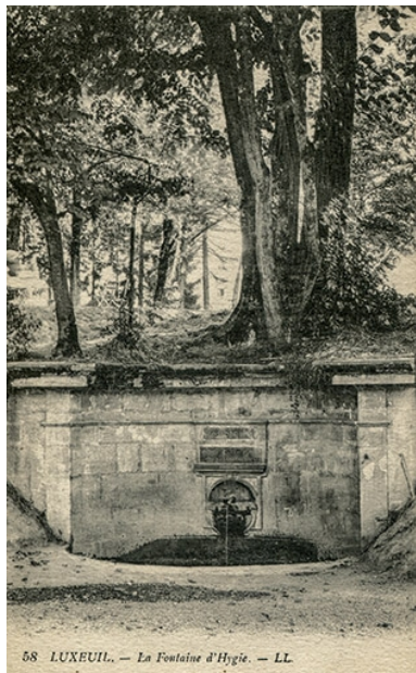
Vue ancienne. Autr. auteur inconnu IVR43_20217000072NUC4A
