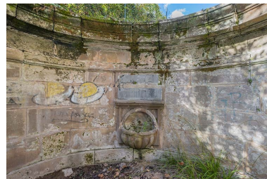
Mur de soutènement. Phot. Jérôme Mongreville IVR43_20207000697NUC4A
