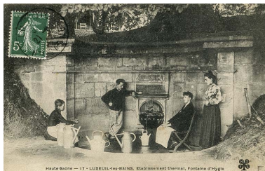
Vue ancienne. Autr. auteur inconnu IVR43_20217000081NUC4A
