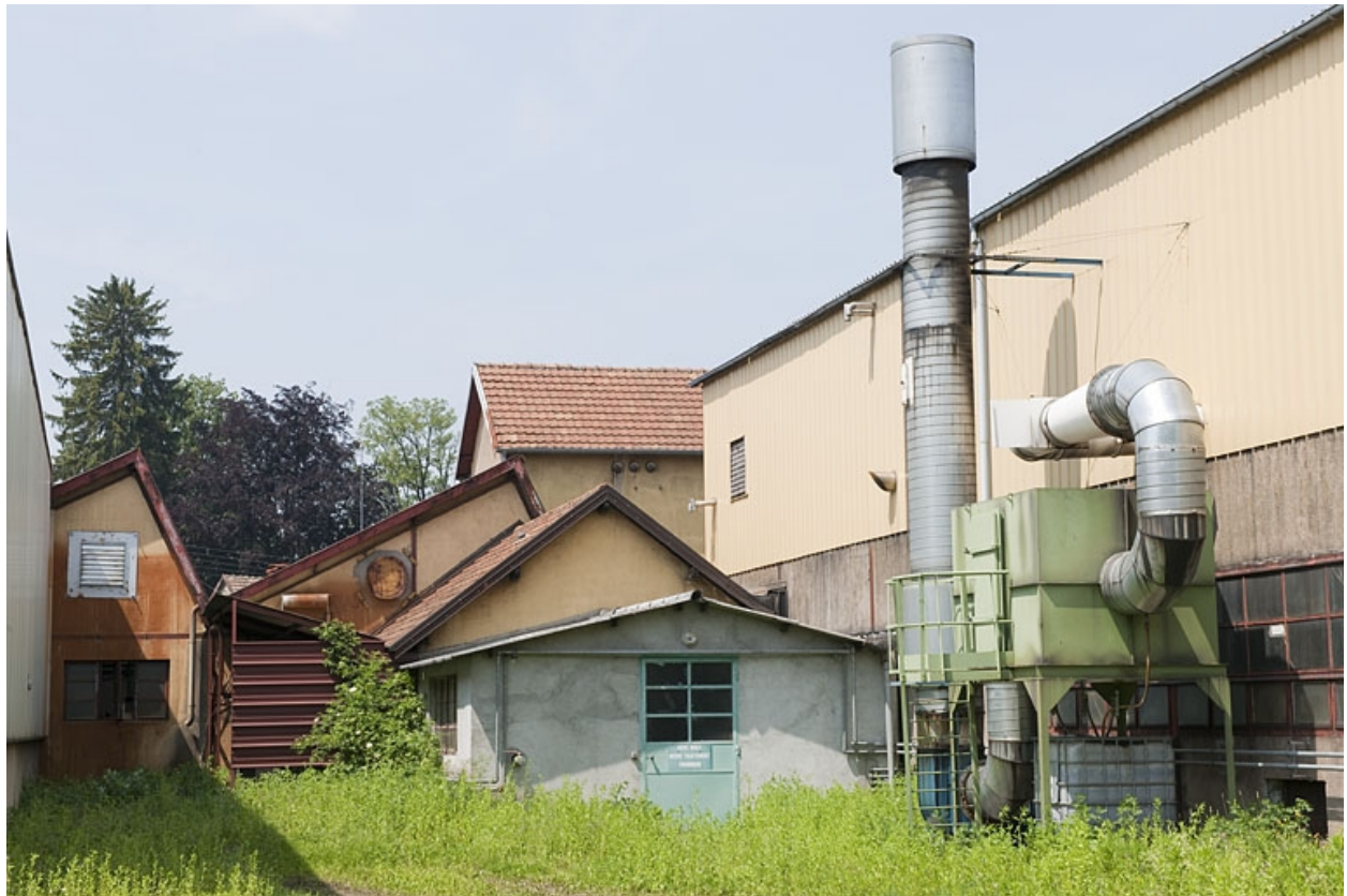
Façades postérieures de bâtiments industriels.
