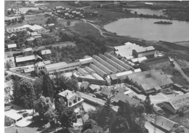
IVR43_20122501567NUC2 Vue aérienne de l'usine depuis le sud-ouest. Phot. Raphaël Favereaux, Phot. Roger Henrard IVR43_20122501569NUC2
