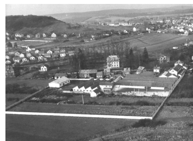
Vue aérienne depuis l'est. Phot. Raphaël Favereaux, Autr. Auclair (photographe)
