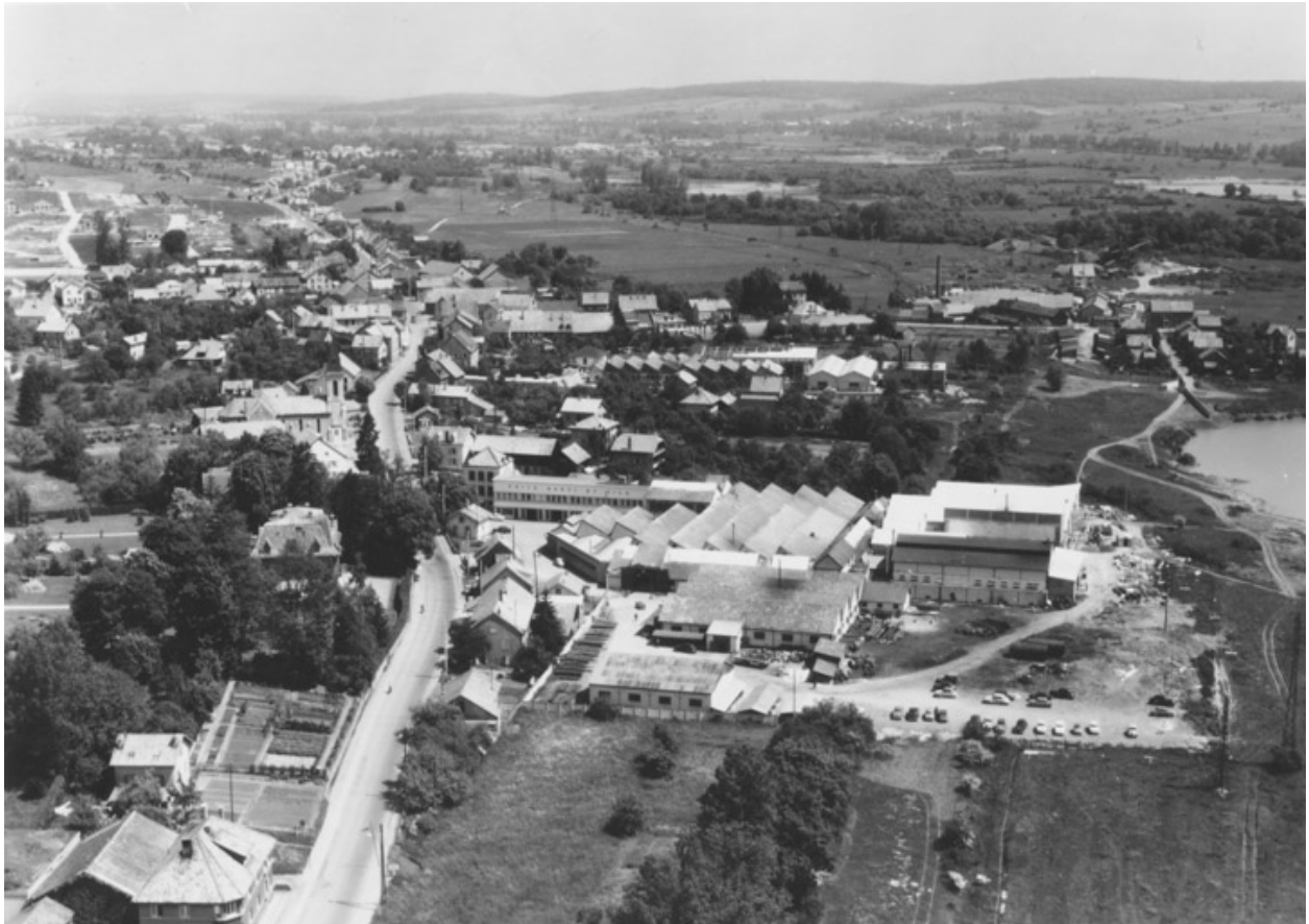
Vue aérienne de l'usine depuis le sud.
