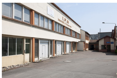
Bâtiments de bureaux vu de trois quarts. Phot. Jérôme Mongreville IVR43_20122501115NUC4A
