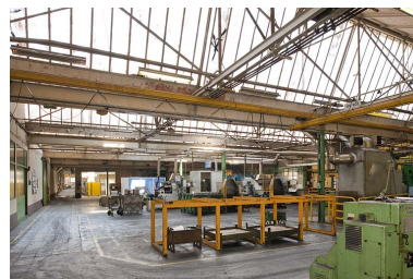
Atelier d'usinage sud. Phot. Jérôme Mongreville IVR43_20122501123NUC4A
