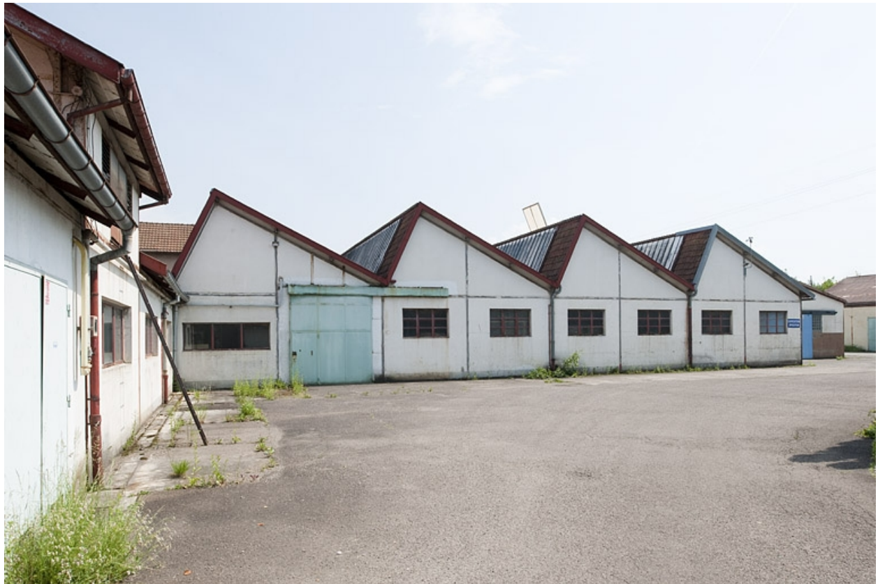
Pignons des shed de l'atelier d'usinage sud.
