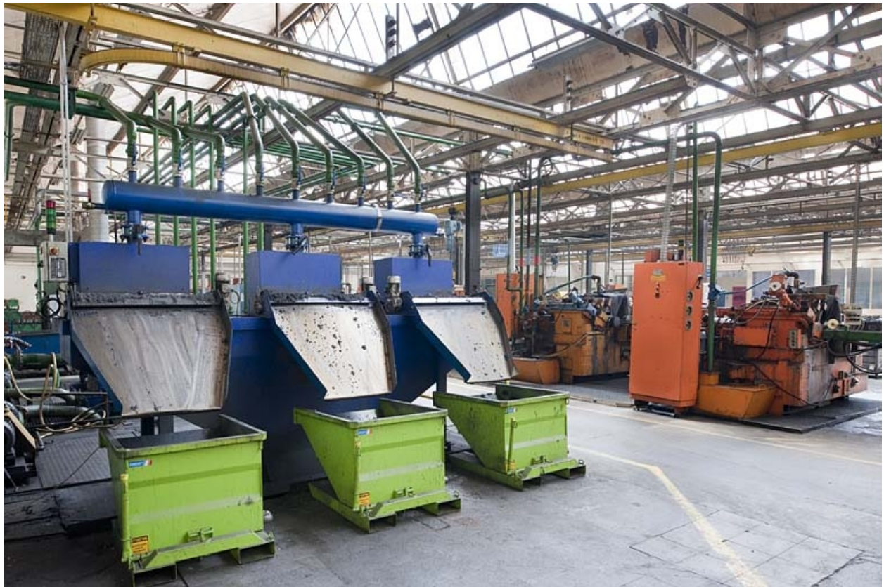
Atelier d'usinage nord.
