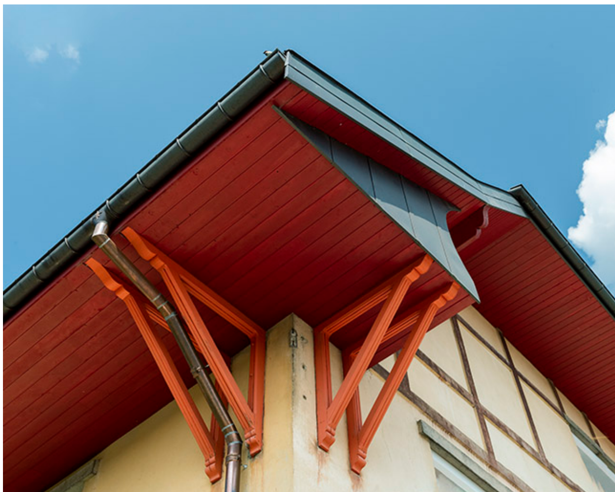
Consoles soutenant l'avant-toit.
