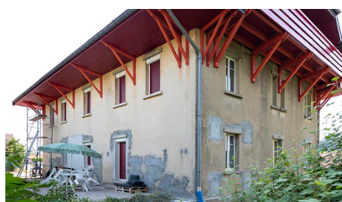
Façades ouest et sud. Phot. Sonia Dourlot IVR43_20192500663NUC4A
