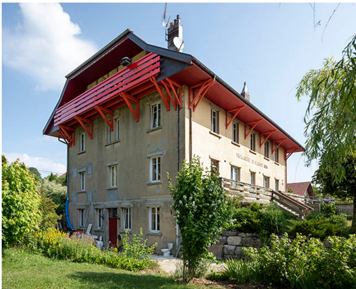
Façades sud et est.
