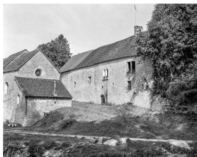
demeure dite maison Buffard, située rue de l'Eglise. Phot. Yves Sancey IVR43_19843900102X
