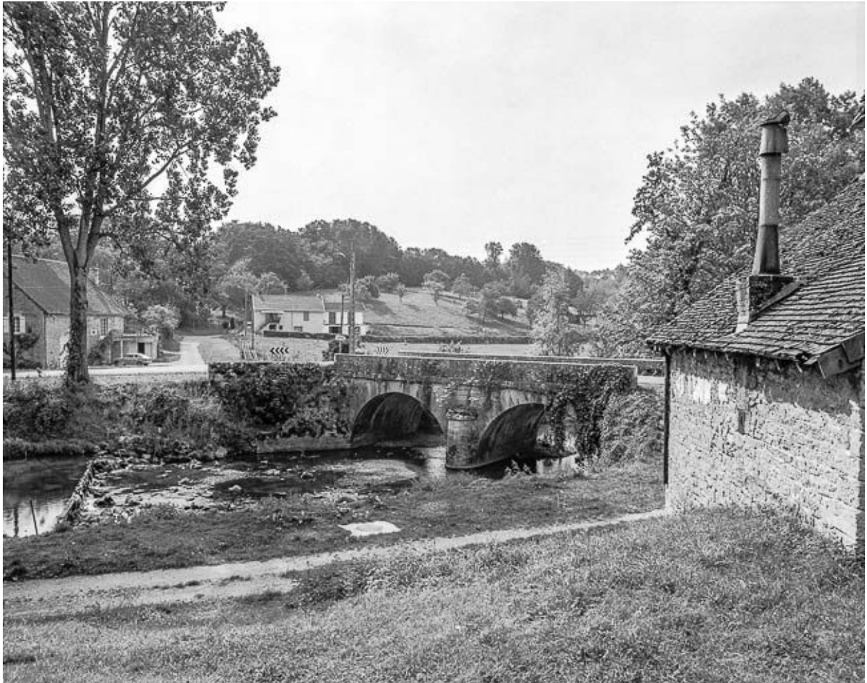
Pont sur la Sorne.
