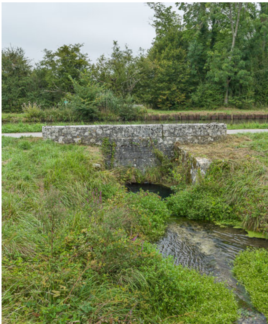
Vue de l'aqueduc.
