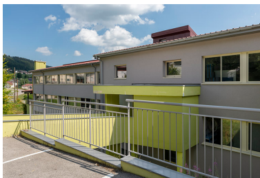
2e bâtiment (vue rapprochée depuis le sud-ouest).
