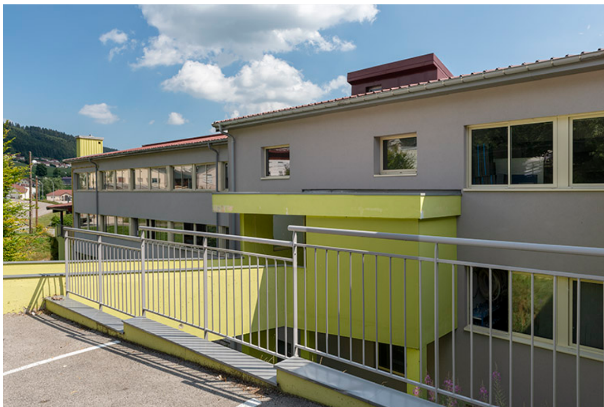
2e bâtiment (vue rapprochée depuis le sud-ouest).
