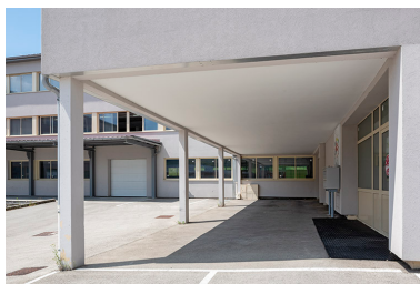
1er bâtiment : galerie ouverte sur la cour. Phot. Sonia Dourlot IVR43_20182501042NUC4A
