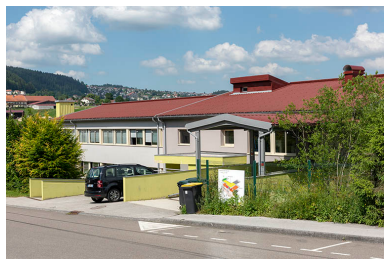
2e bâtiment, vu du sud-ouest.
