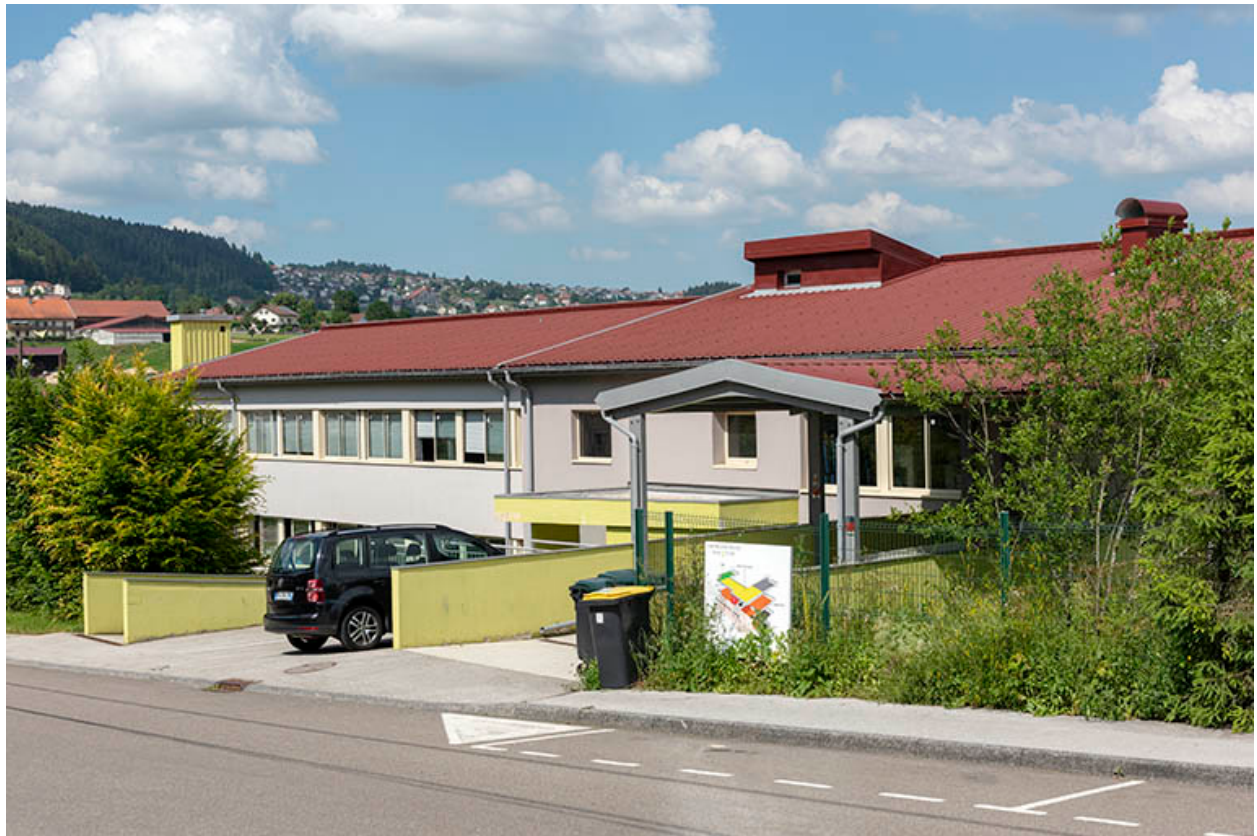
2e bâtiment, vu du sud-ouest.
