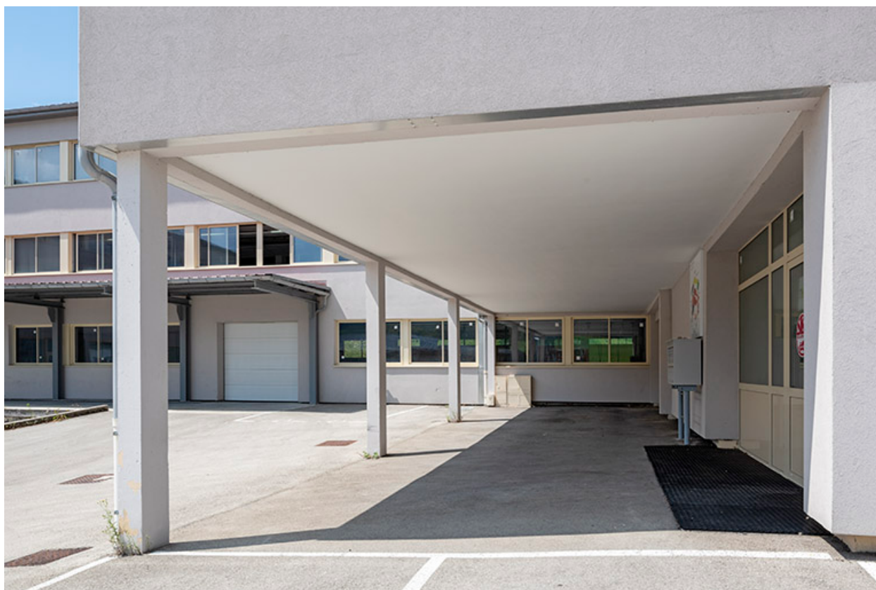
1er bâtiment : galerie ouverte sur la cour.
