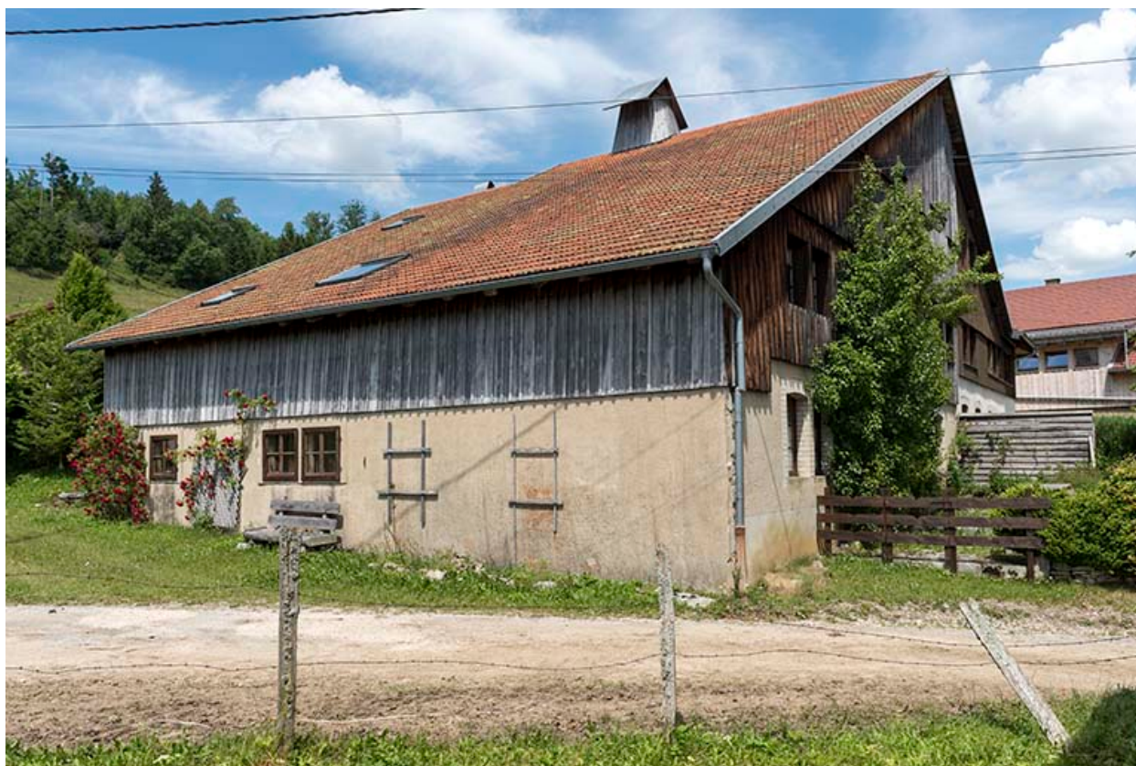
Façades antérieure et latérale gauche.
