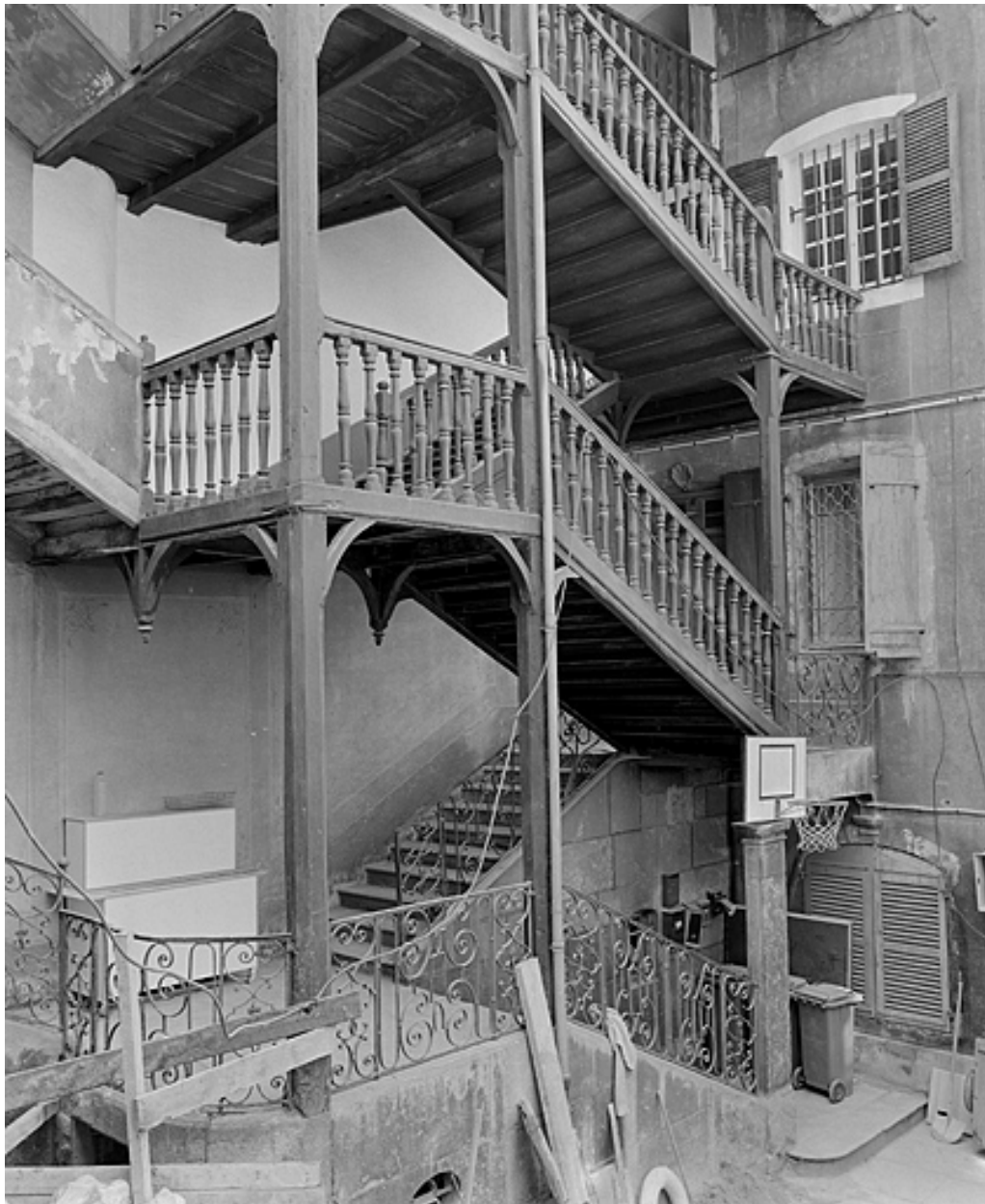
L'escalier s'ouvrant sur la cour.
