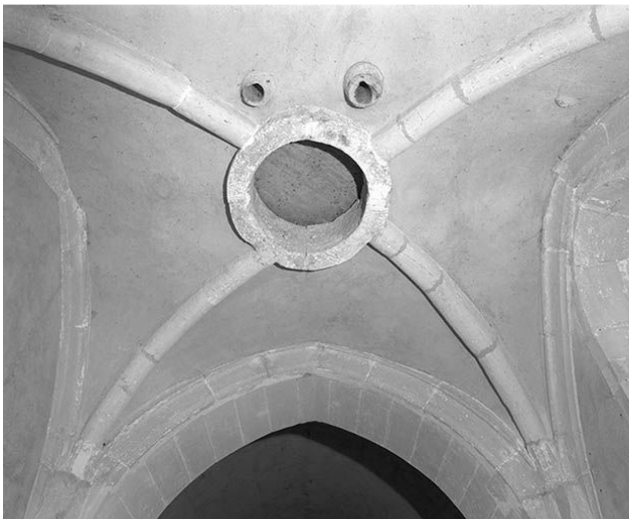
Voûte du vestibule.
