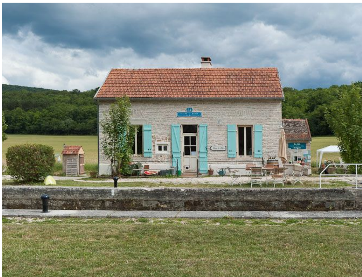
Vue de face de la maison éclusière.
