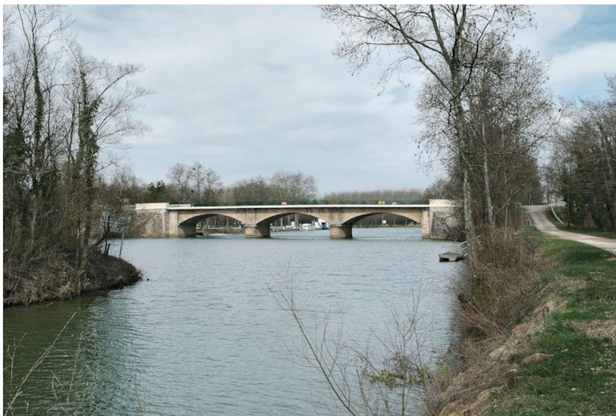
Le pont de Cuisery, vu d'amont.
