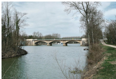
Le pont de Cuisery, vu d'amont.
