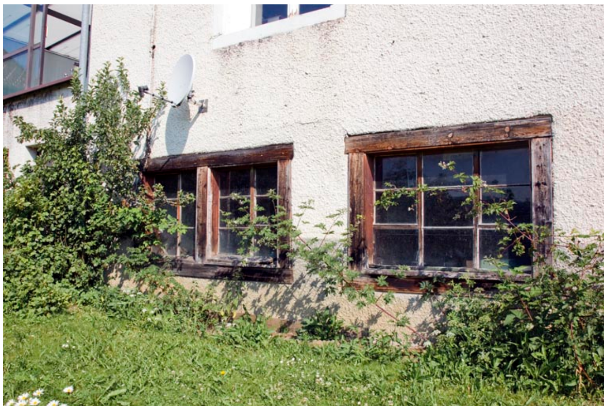
Atelier : fenêtres en façade antérieure.
