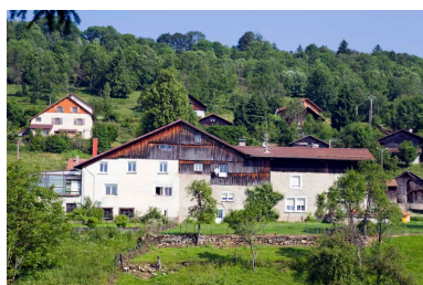
Façade latérale droite. Phot. Yves Sancey IVR43_20132501247NUC2A
