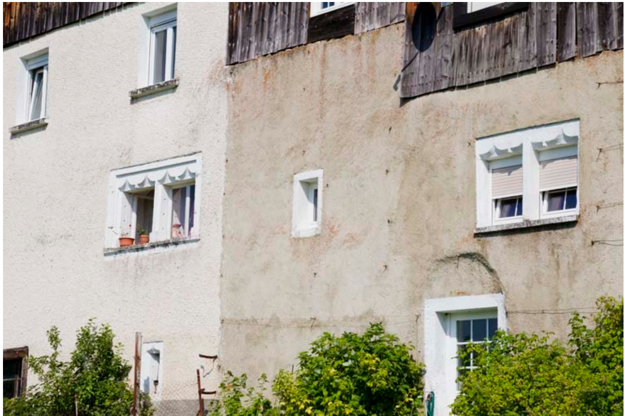
Façade latérale droite : baies.
