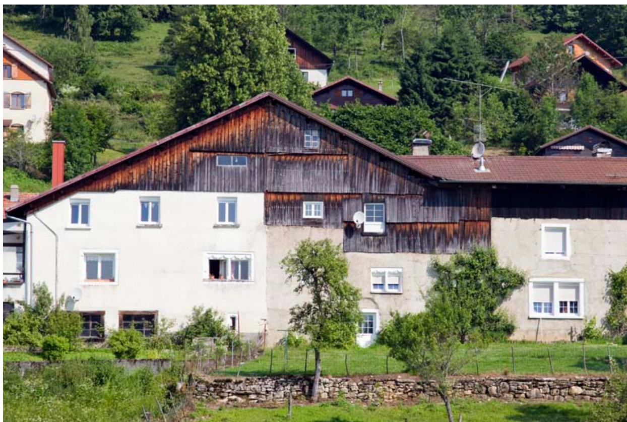
Façade latérale droite (vue rapprochée).
