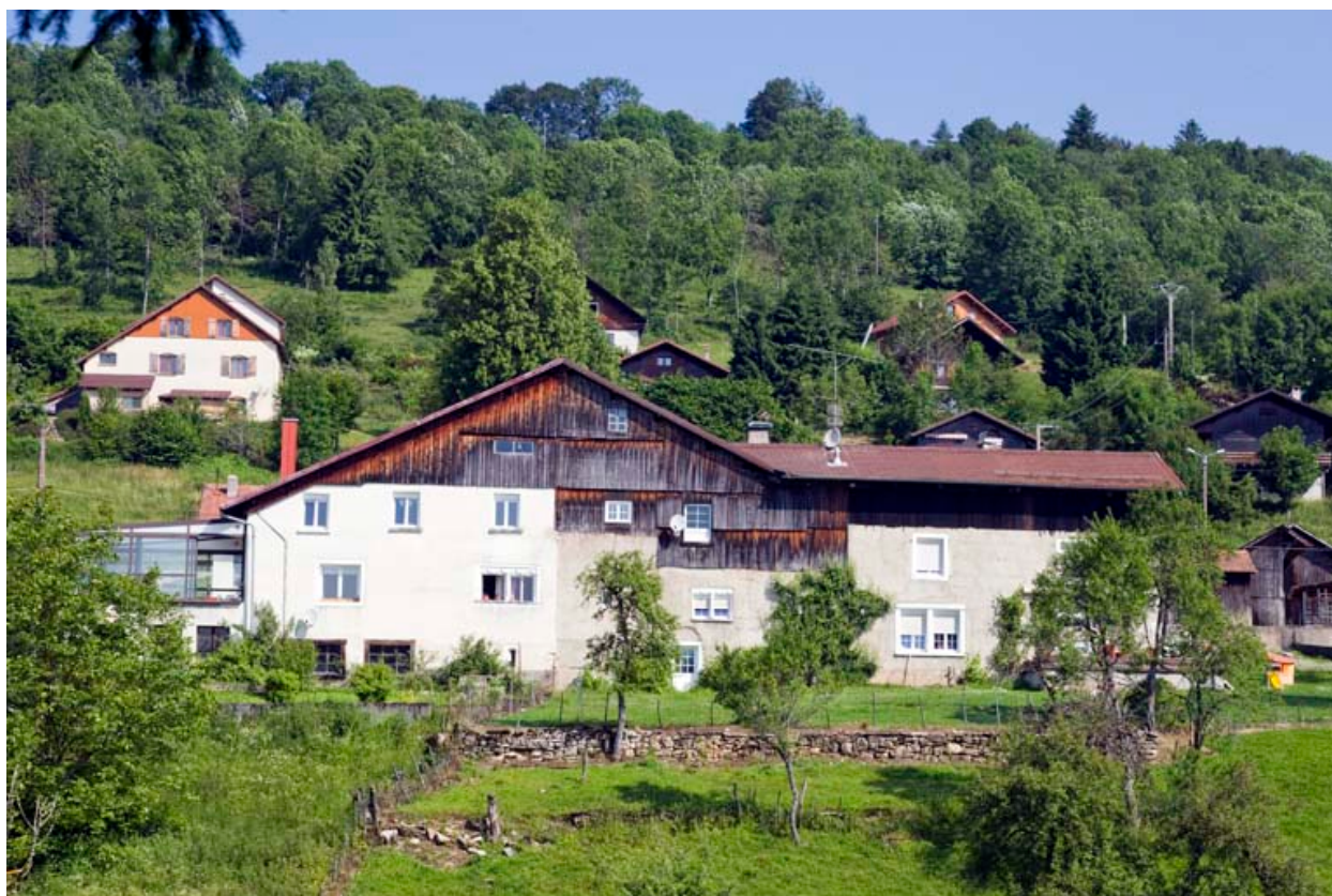
Façade latérale droite.
