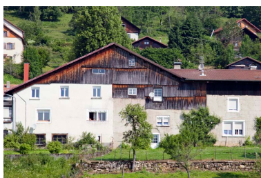
Façade latérale droite (vue rapprochée). Phot. Yves Sancey IVR43_20132501248NUC2A
