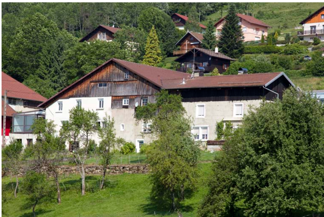
Vue d'ensemble rapprochée depuis le sud-est.
