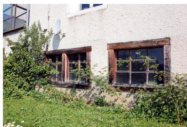
Atelier : fenêtres en façade antérieure.
