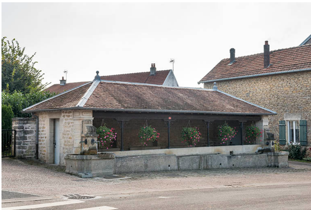
La fontaine-lavoir, Grande rue.
