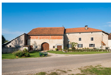
Ferme, vue générale, Grande rue. Phot. Jérôme Mongreville IVR43_20167001604NUC4A
