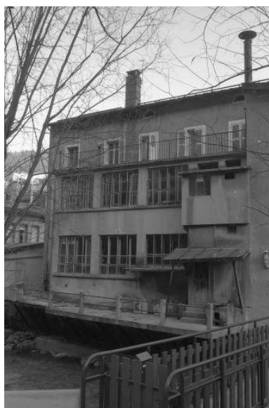
Façade postérieure. Phot. Laurent Poupard IVR43_19913901503Z
