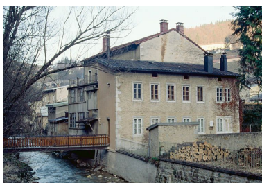
Vue d'ensemble depuis la Bienne. Phot. Laurent Poupard IVR43_19913901505ZA
