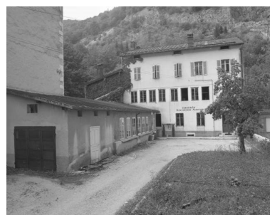
Cour et façade antérieure. Phot. Jérôme Mongreville IVR43_19913900889X
