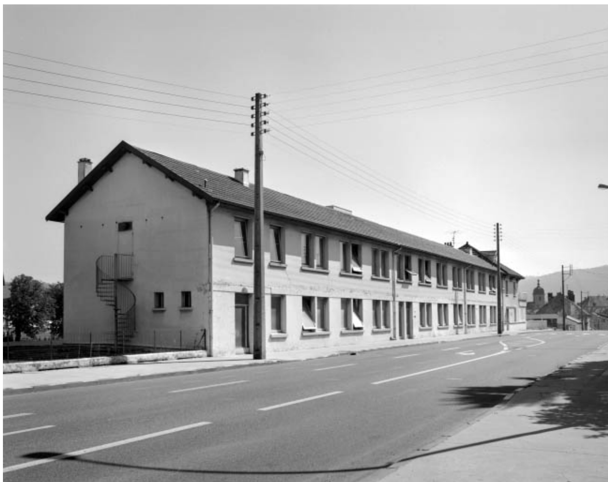
Atelier de fabrication depuis le nord-ouest.
