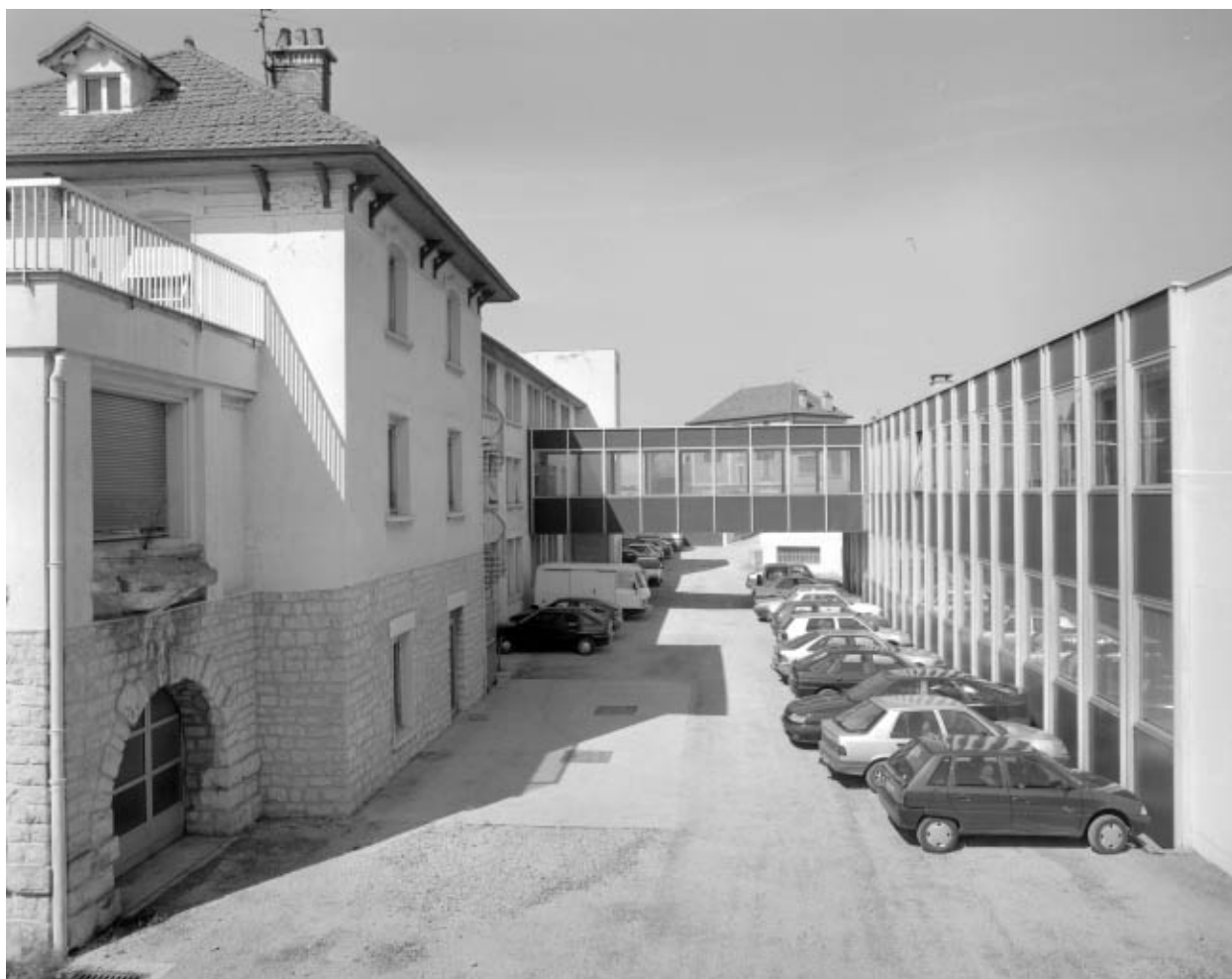
Ateliers de fabrication depuis le sud.
