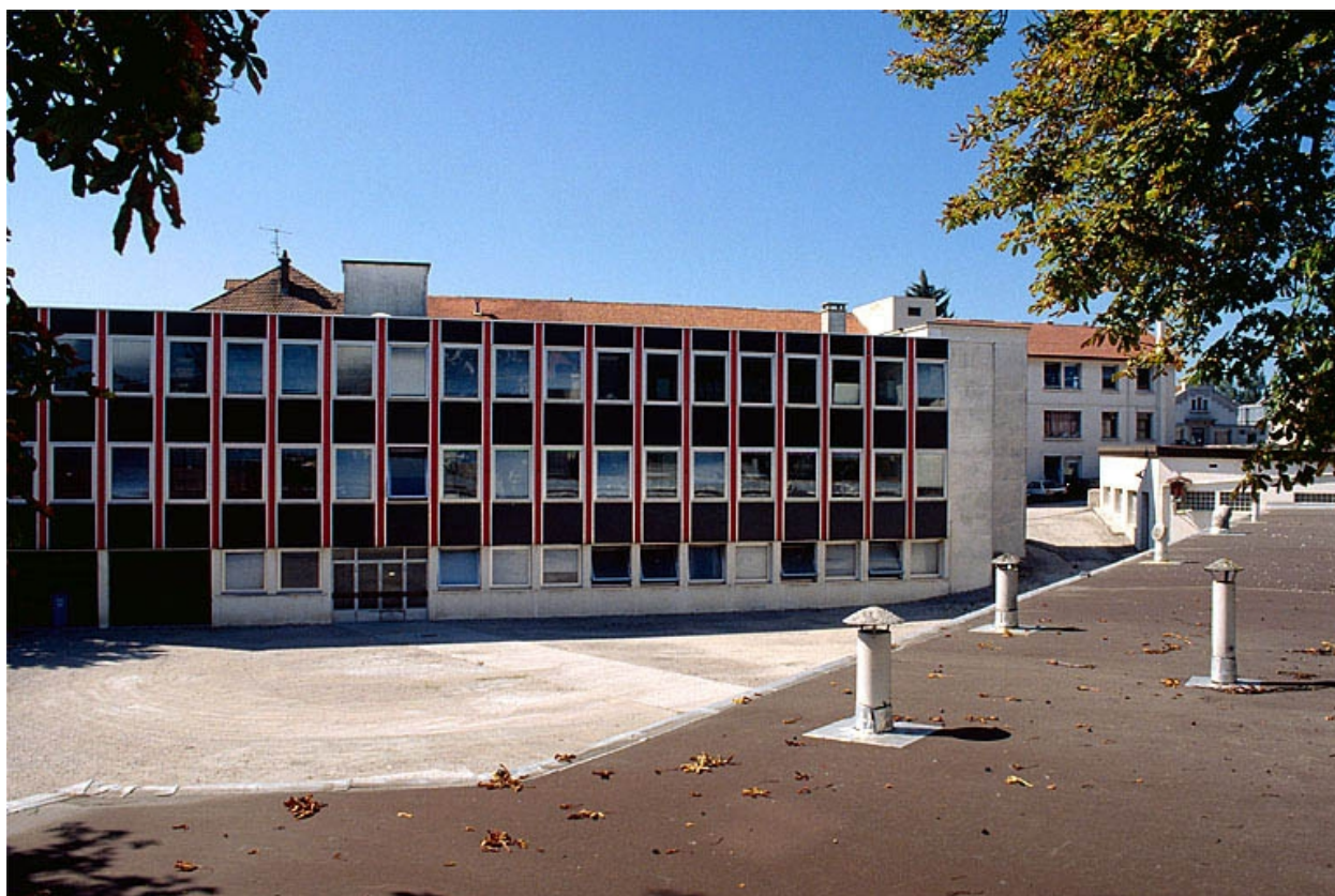
Façade sur cour d'un atelier de fabrication.
