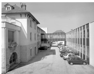
Ateliers de fabrication depuis le sud.
