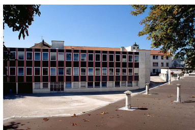
Façade sur cour d'un atelier de fabrication.
