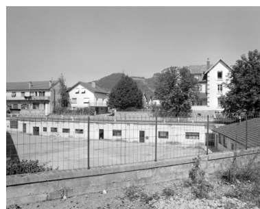
Atelier de fabrication (décapage).
