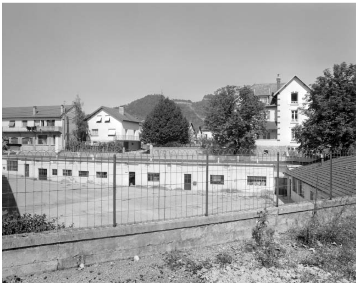
Atelier de fabrication (décapage).
