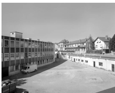
Vue plongeante sur la cour de l'usine.
