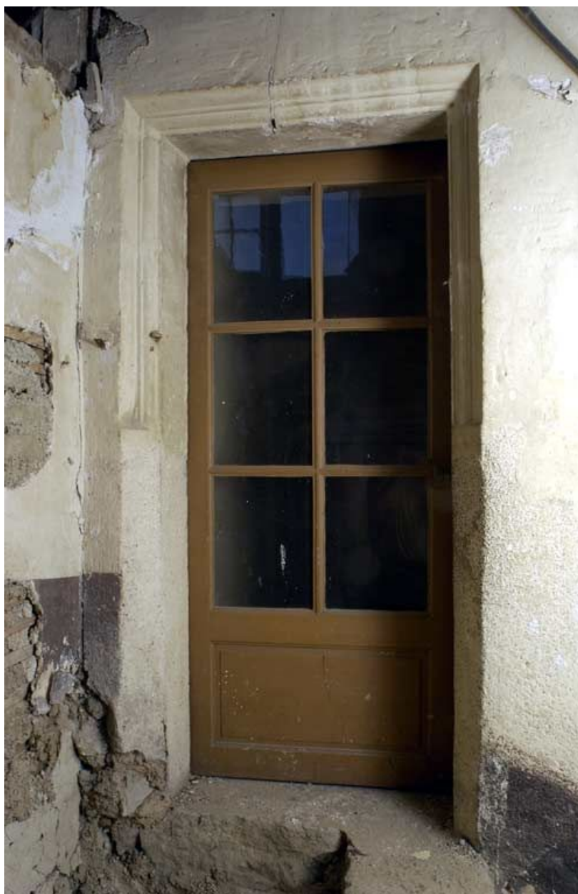
Ancien hôtel du gouverneur : fenêtre transformée en porte au fond du passage donnant accès au laboratoire.
