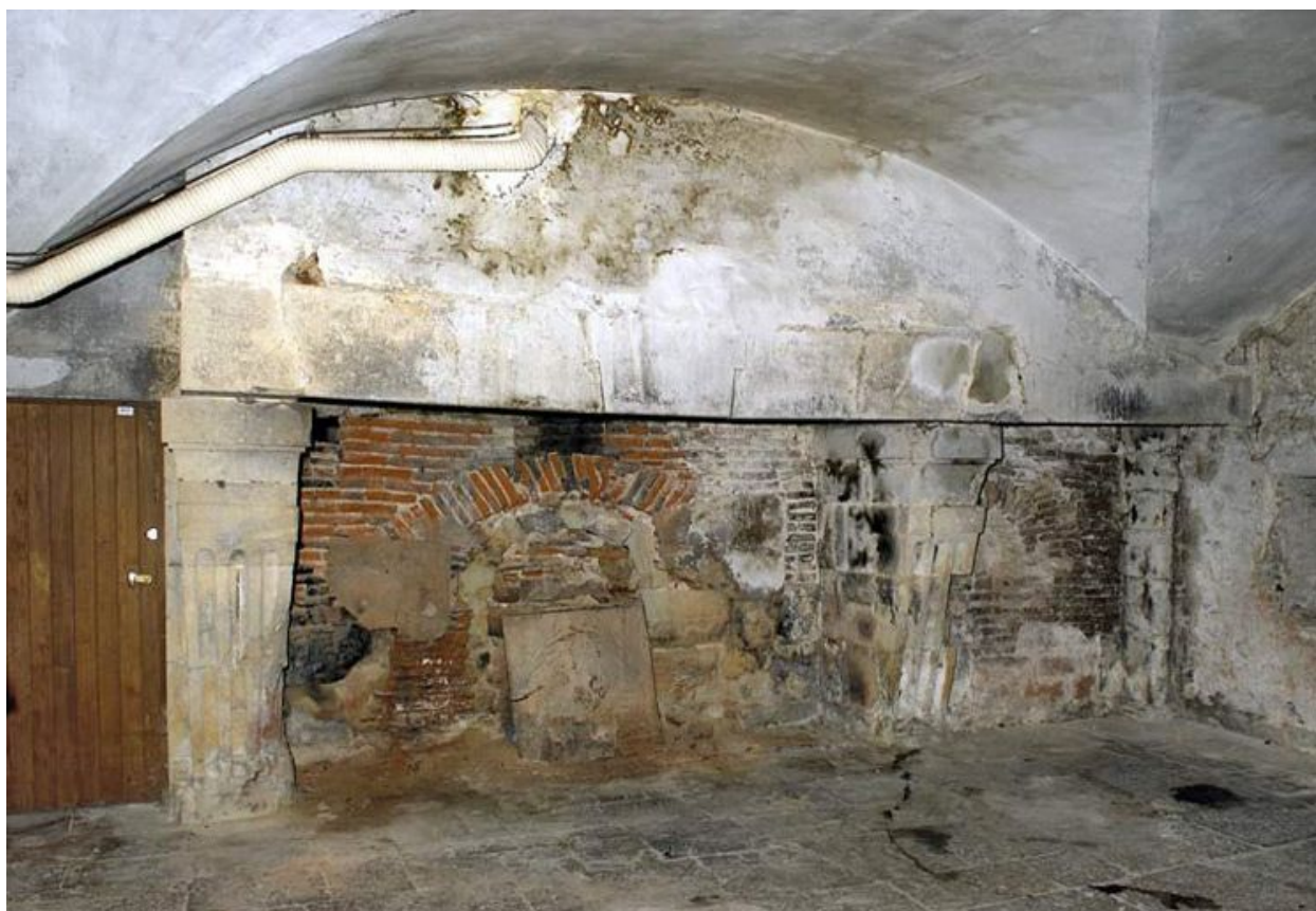
Ancien hôtel du gouverneur : sous-sol, cheminée.
