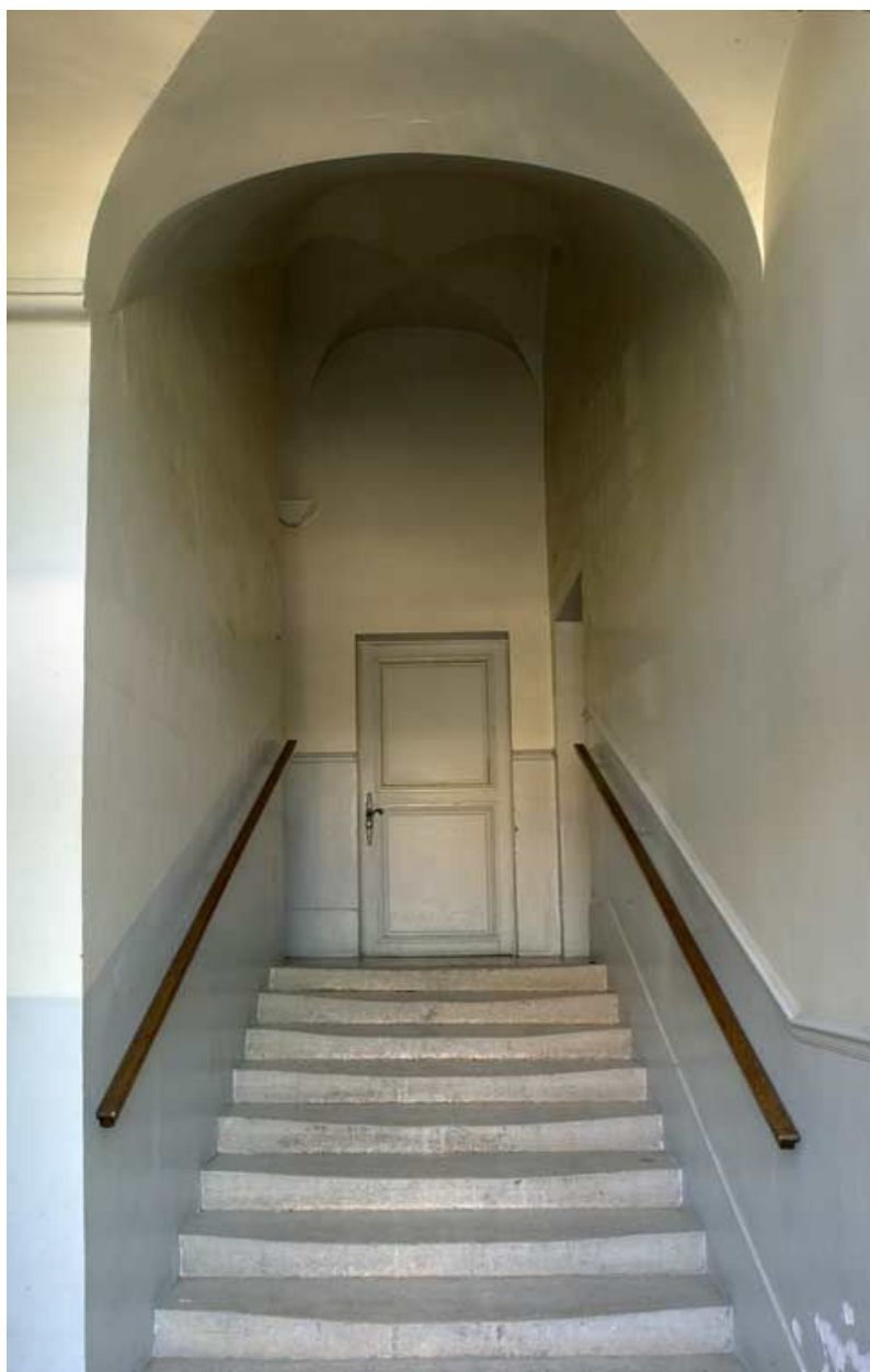
Ancien hôtel du gouverneur : escalier rampe sur rampe, 2e volée donnant accès au rez-de-chaussée surélevé.
