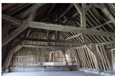
Aile droite : charpente. Phot. Michel Thierry IVR26_20042100560NUC2A
