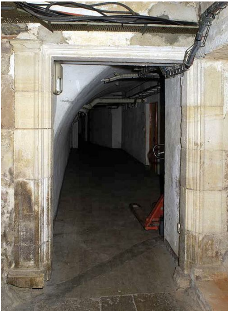
Ancien hôtel du gouverneur : sous-sol, porte.
