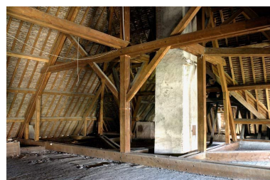
Aile droite : charpente. Phot. Michel Thierry IVR26_20042100558NUC2A
