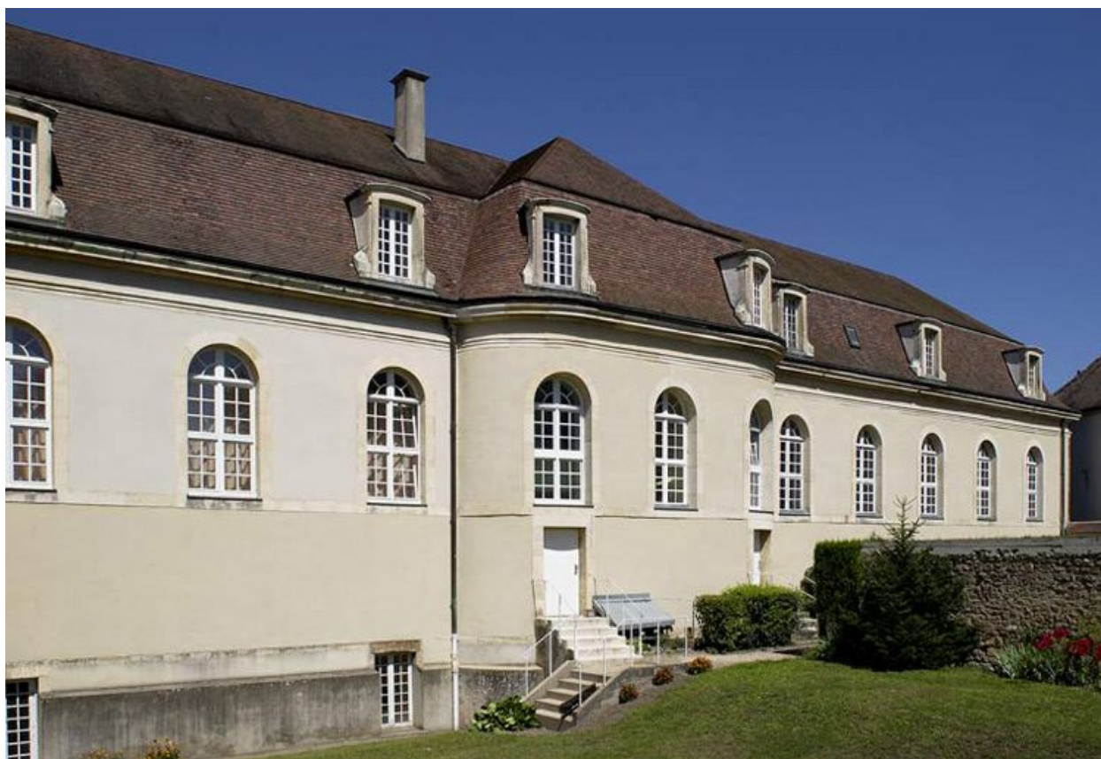
Aile gauche dite fondation Arnault : élévation postérieure.
