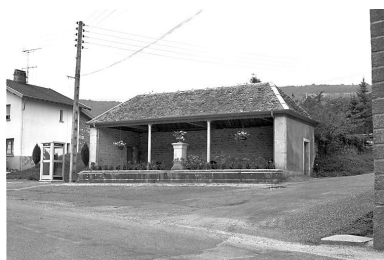
Fontaine-lavoir située rue de la Fontaine. Phot. Yves Sancey IVR43_19802501136X
