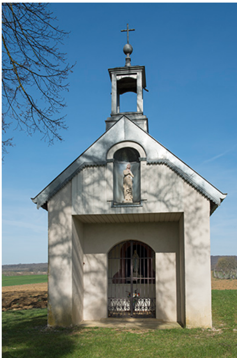
Chapelle saint-Brice. Vue de face.
