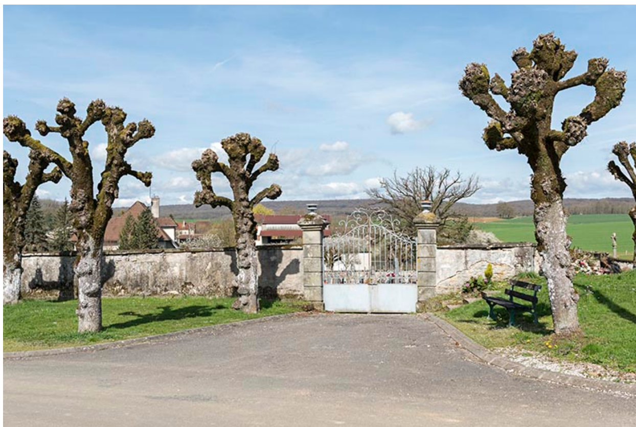
Grille d'entrée et mur d'enceinte du cimetière.
