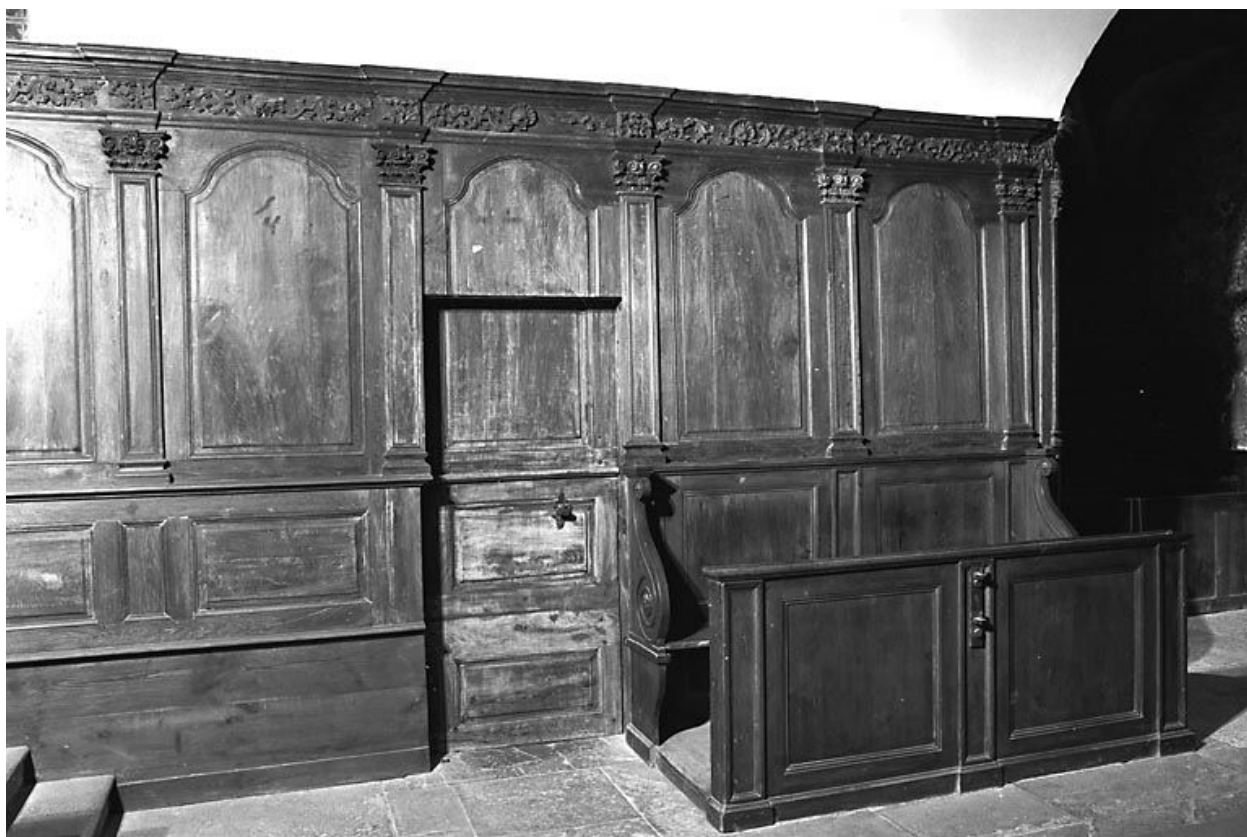
Côté sud des lambris de demi-revêtement.
