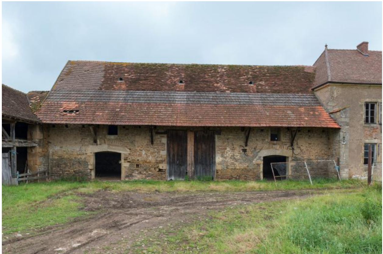
Façade antérieure de la grange
