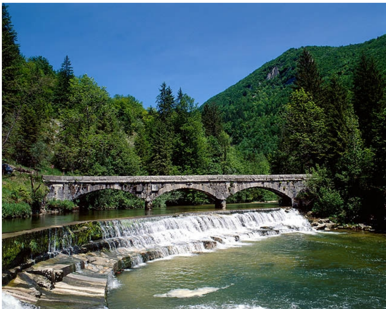
Vue générale depuis l'aval.
