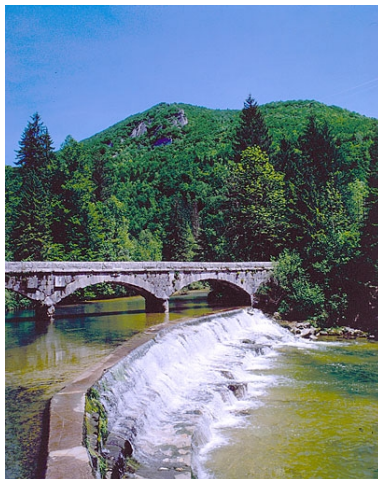
Partie droite depuis l'aval. Phot. Jérôme Mongreville IVR43_19973900763XA
