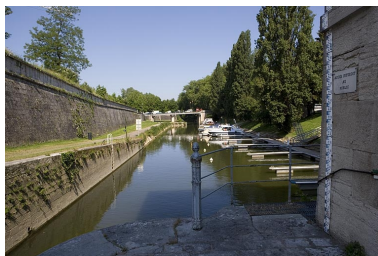
Le port de Saint-Paul et la cortine, depuis le moulin. Phot. Yves Sancey IVR43_20062500247NUCA
