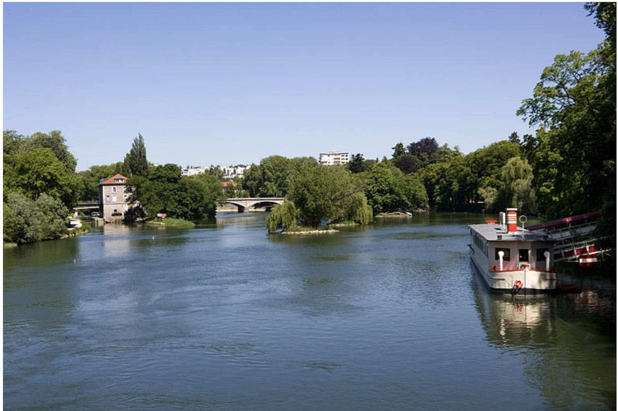
Vue d'ensemble depuis l'amont.
