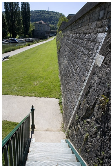
Le chemin de halage et la cortine, depuis le pont de la République. A droite, échelle limnimétrique (ou hydrométrique). Phot. Yves Sancey IVR43_20062500173NUCA
