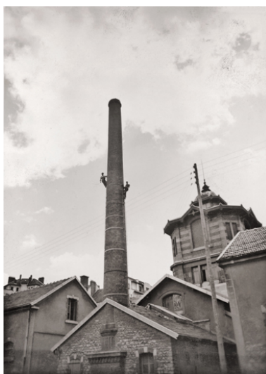
Cheminée de la chaufferie (vers 1950). Autr. auteur inconnu IVR43_20232500635NUC2A
