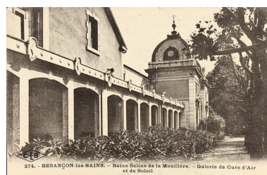
Façade latérale (vers 1930).
