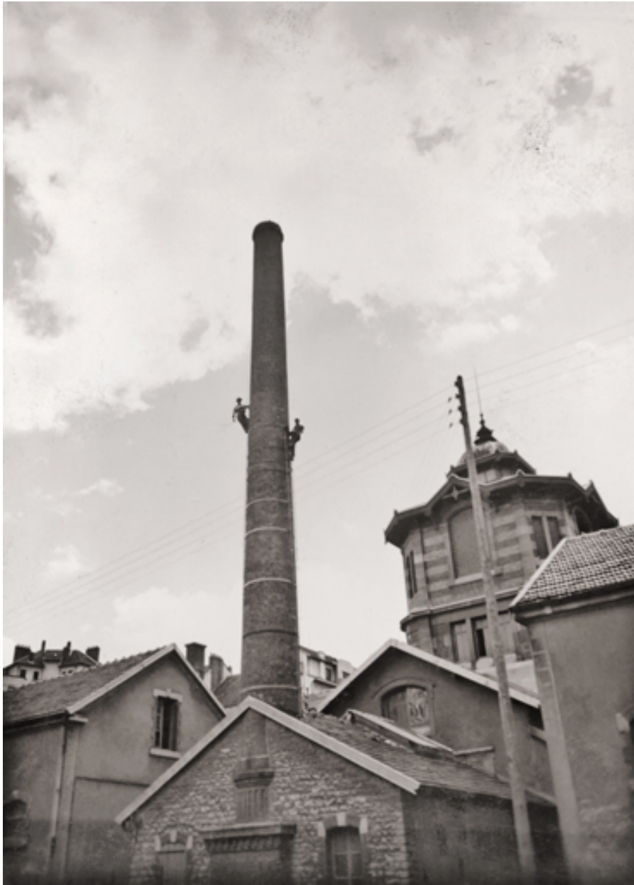
Cheminée de la chaufferie (vers 1950).
