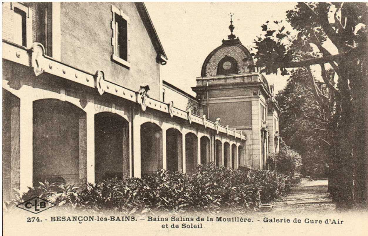
Façade latérale (vers 1930).
