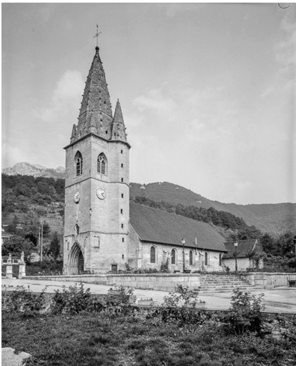
Façade antérieure et face latérale droite.
