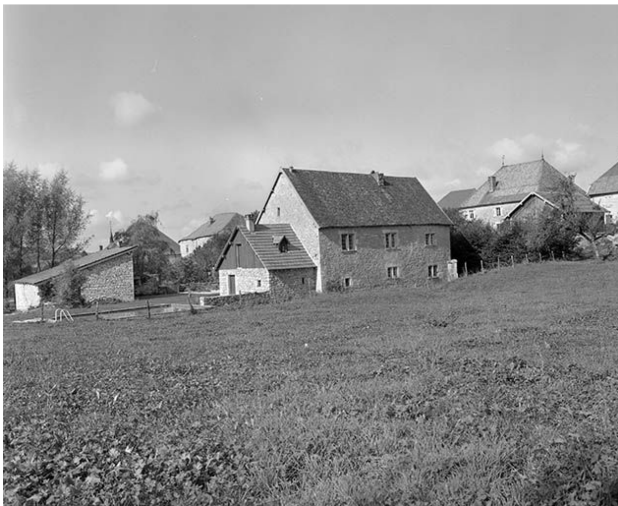
Façade postérieure vue depuis le pré.
