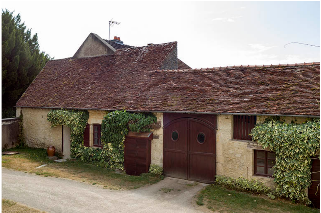
Vue générale des communs.
