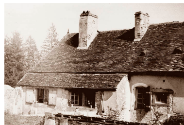
[Vue partielle des communs], 1955. Phot. Sonia Dourlot, Autr. Raymond Liard IVR43_20177001327NUCA
