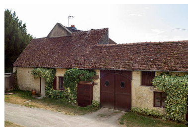
Vue générale des communs.
