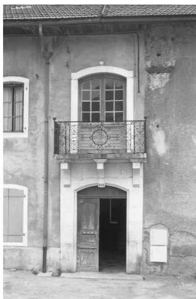
Logement patronal : porte d'entrée et balcon. Phot. Laurent Poupard IVR43_19913901524Z
