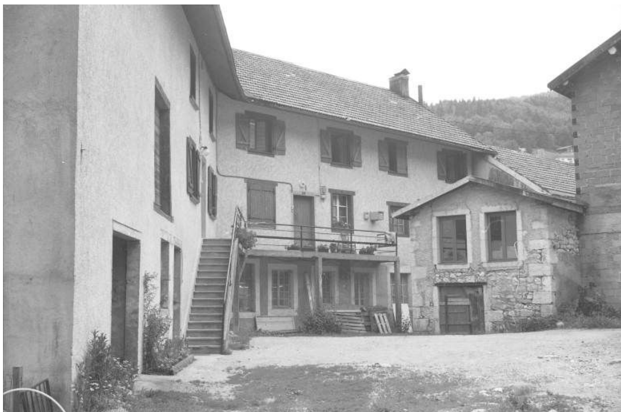
Ancienne clouterie : façades sur la cour.
