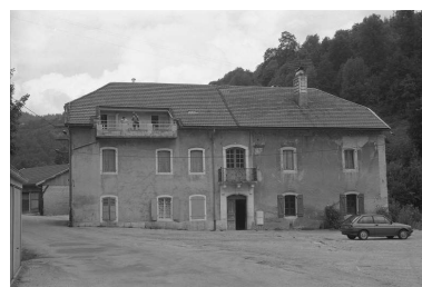
Logement patronal. Phot. Laurent Poupard IVR43_19913901520Z
