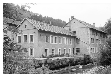
Ancienne clouterie : façades sur la Bienne. Phot. Laurent Poupard IVR43_19913901528Z
