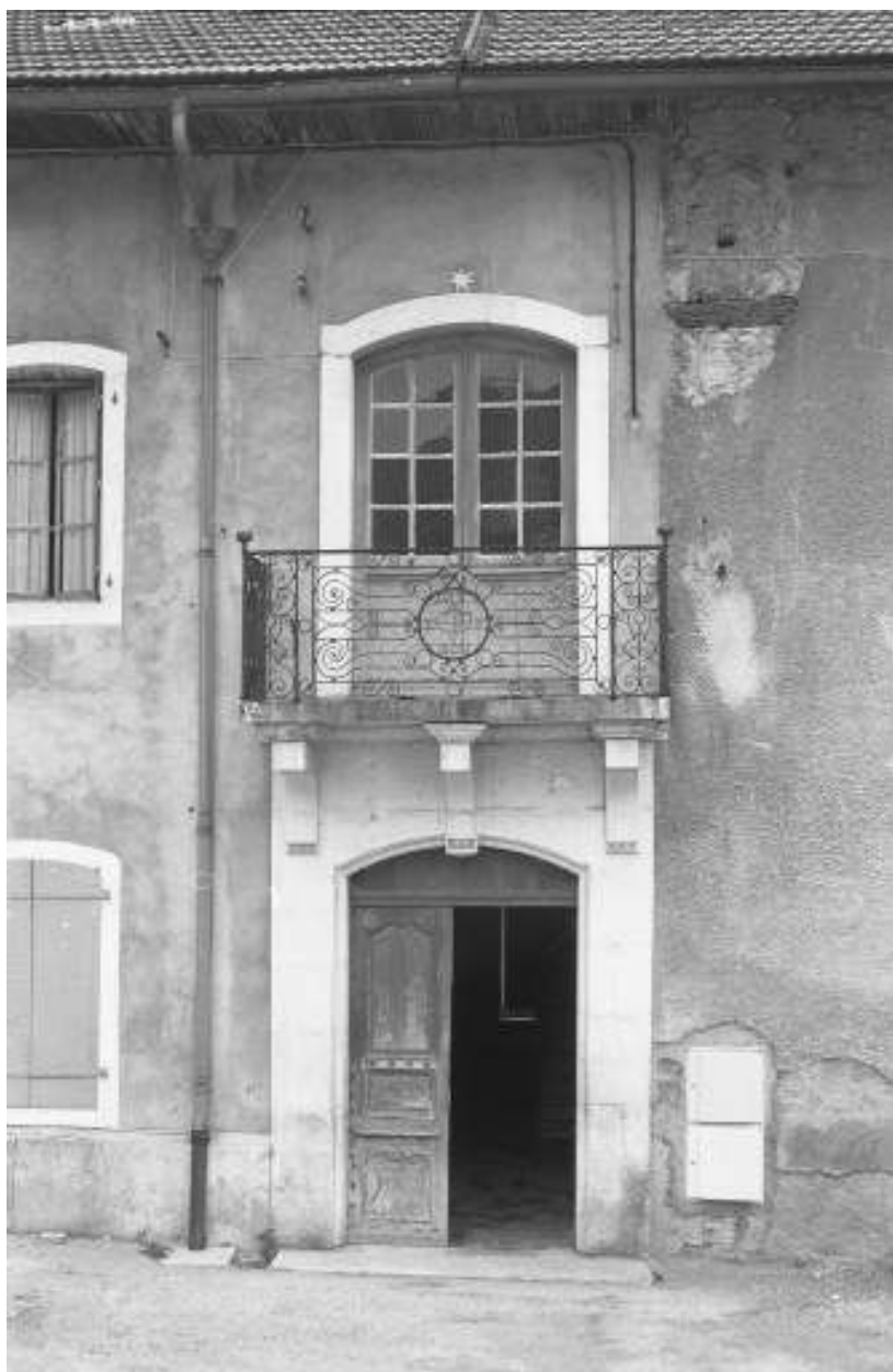
Logement patronal : porte d'entrée et balcon.
