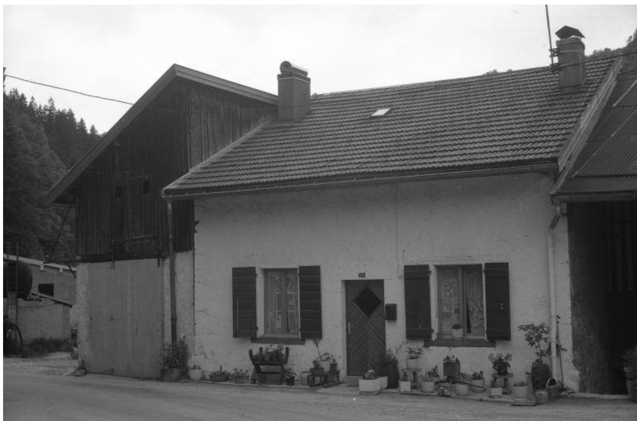
Ancien logement d'ouvriers.
