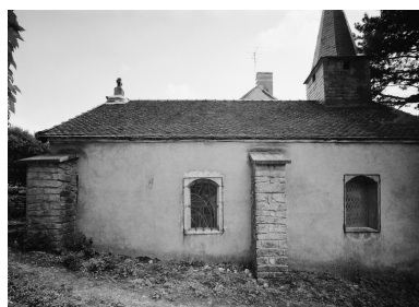
Elévation gauche. Phot. Michel Thierry IVR26_19792100089V
