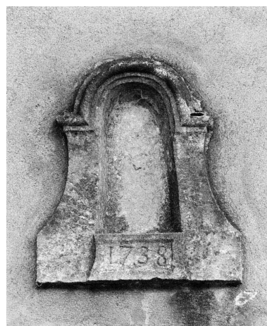
Niche de la façade. Phot. Michel Rosso IVR26_19792100092X
