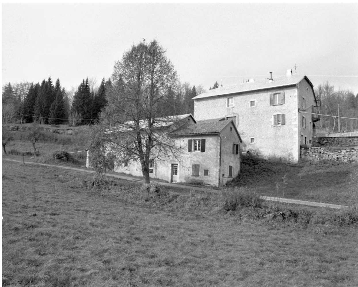
Façade postérieure, vue générale.
