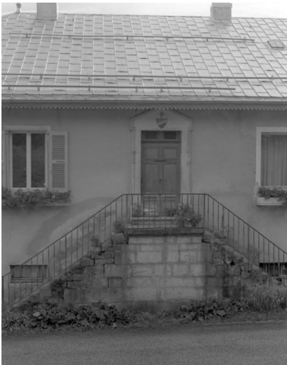
L'escalier menant au logis.
