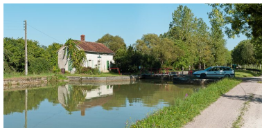
Vue du site d'écluse depuis l'amont. Phot. Pierre-Marie Barbe-Richaud IVR26_20112103984NUC4AQ
