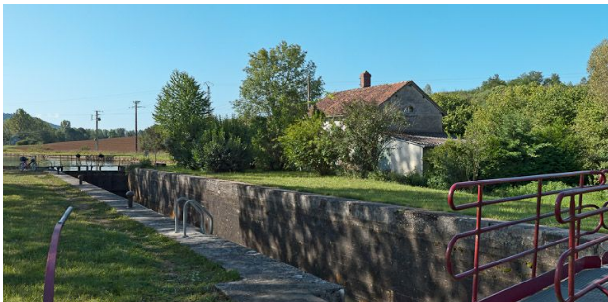
Vue d'ensemble du site d'écluse.
