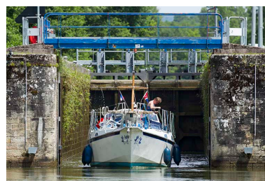
Bateau avalant sortant de l'écluse. Phot. Sonia Dourlot IVR43_20157000951NUC2A
