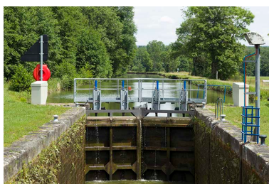
Portes amont fermées : le sas se vide. Phot. Sonia Dourlot IVR43_20157000950NUC2A
