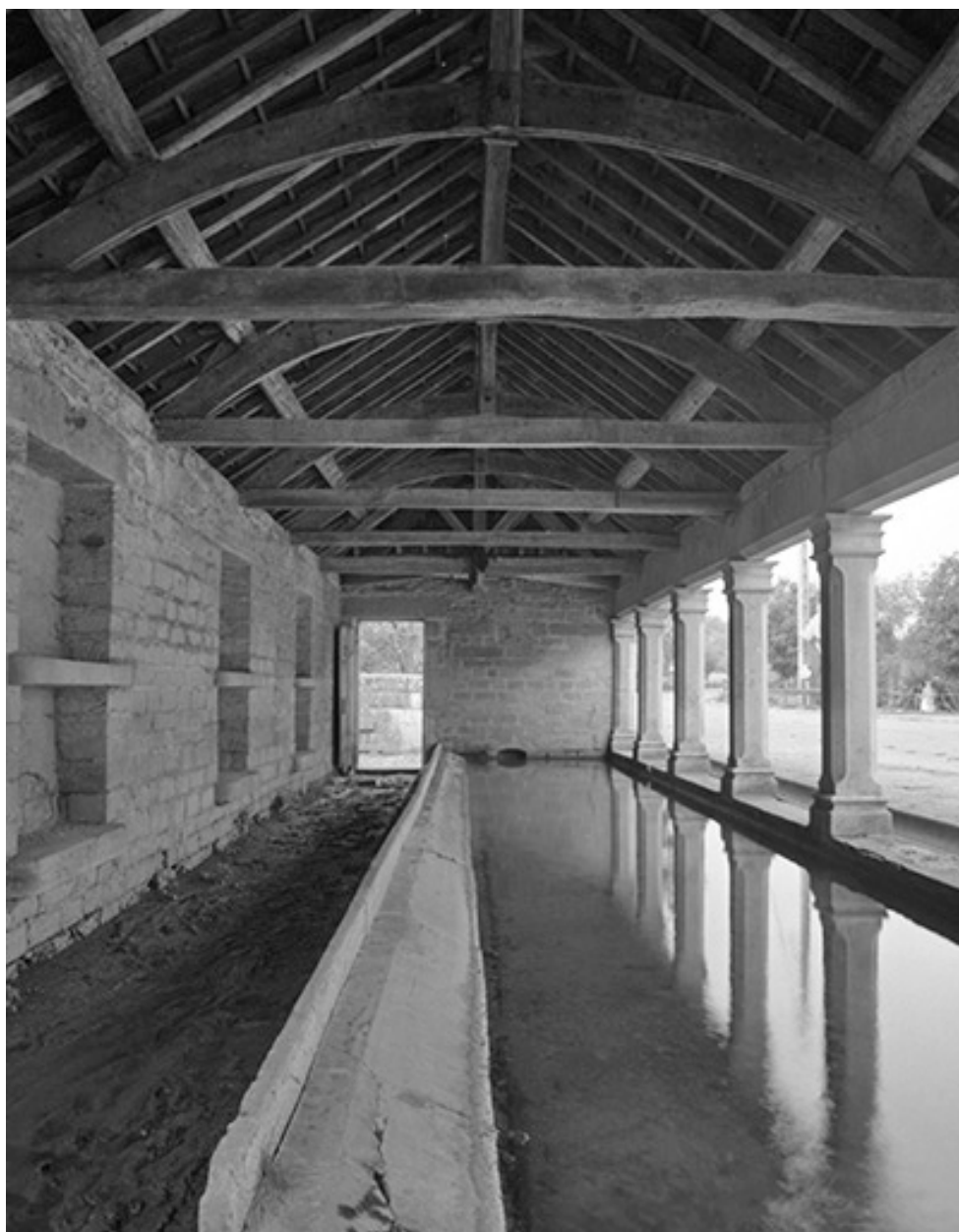
Détail : intérieur du lavoir.
