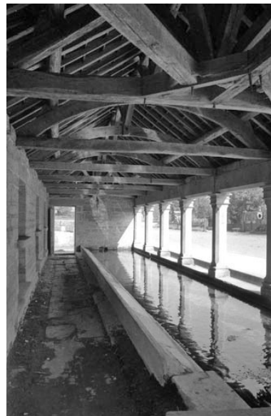
Détail : intérieur du lavoir. Phot. Bernard Lardière IVR43_19817000582Z
